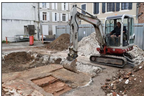
Figure 13 : Les structures contemporaines ont été nettoyées, enregistrées et relevées avant d'être fouillées à la pelle mécanique.
