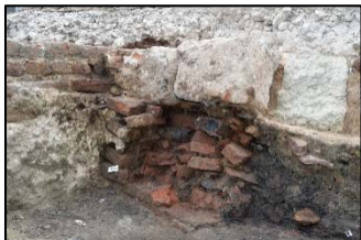
Figure 59 : Vue de la maçonnerie 3066 du MUR324.
