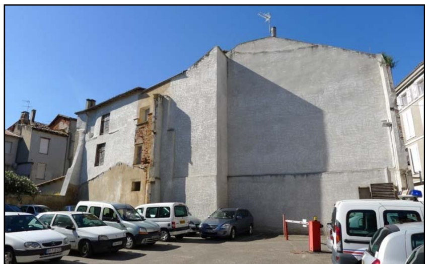
Figure 28 : Le parking occupant les parcelles DK0551 et DK0552 vu depuis le sud.
