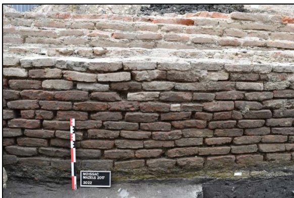
Figure 51 : Détail du parement septentrional de la maçonnerie 3022 du MUR307 ; en arrière-plan, le MUR303.
