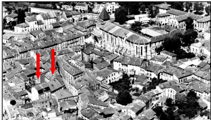
Figure 27 : Rue Caillavet, abbatiale depuis le sud-est, Cl. Inventaire Midi-Pyr. 85.82.1080. NR. Coll. Henrard, 1955. Les flèches rouges indiquent, sur les parcelles DK0551 et DK0552, l'emplacement des deux maisons détruites en 2000.
