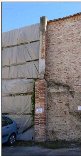
Figure 87 : Le vestige du MUR02-551, soit la partie conservée en élévation du MUR304 contre le mur méridional de la parcelle.
