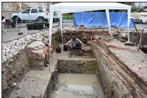
Figure 17 : Le site après l'orage du 21 juillet 2017.
