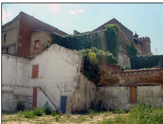
Figure 30 : [Le fond des parcelles DK551 et 552 après la démolition des bâtiments], 2002, Moissac, Serv. urbanisme, [sans cote]
