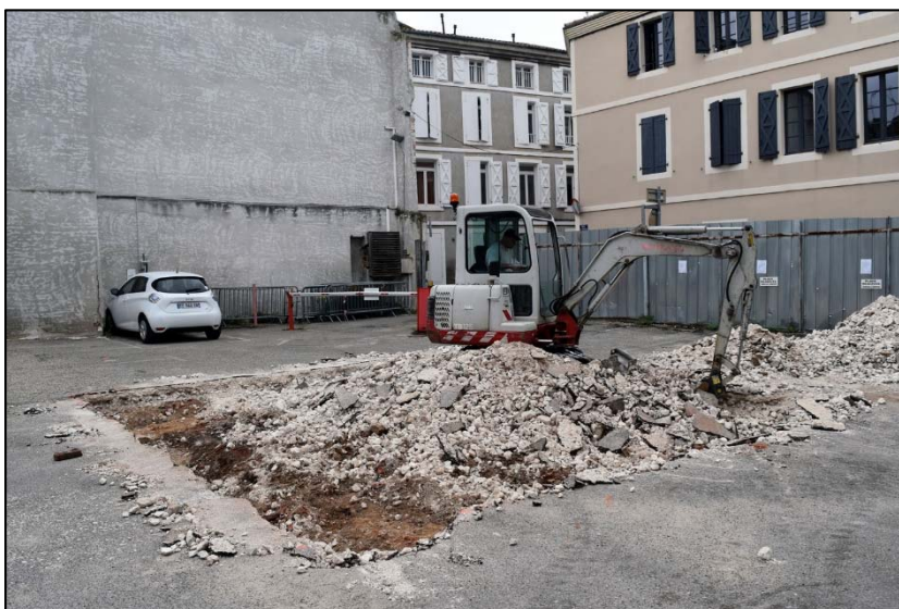
Figure 91 : Le revêtement de goudron 3001 et les niveaux de castine (3002 et 3003) du parking (SOL300) en cours d'enlèvement lors du décapage.
