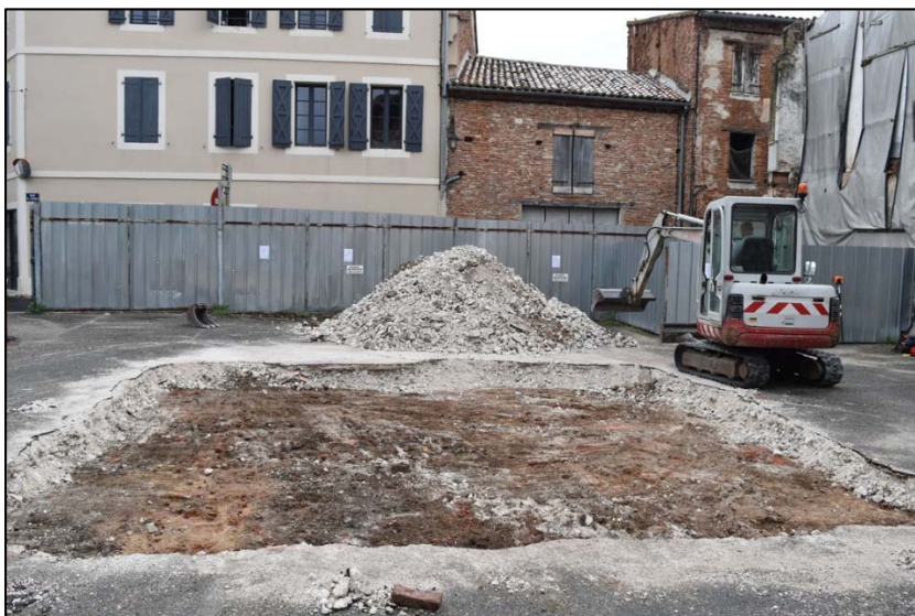
Figure 12 : Le site en cours de décapage, après l'enlèvement de la castine.
