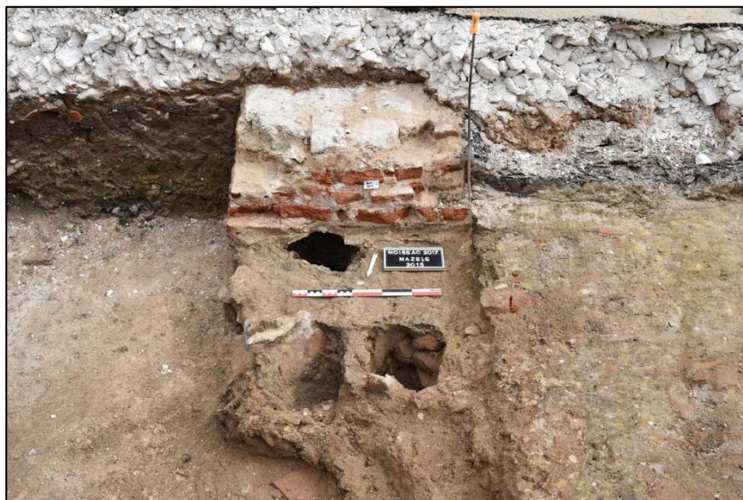
Figure 88 : La maçonnerie 3012 du MUR304 après démontage. On remarque les trous non colmatés correspondant à l'empreinte des pieux de fondation (3015).
