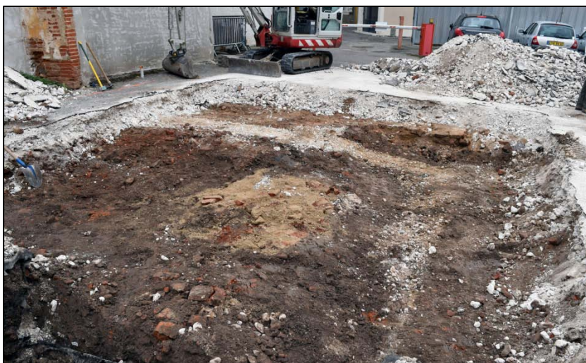
Figure 9 : Le site après décapage
