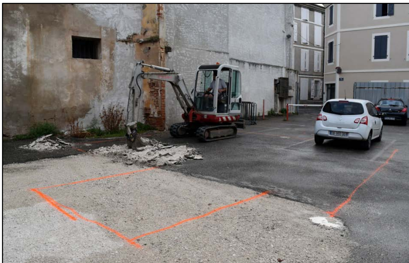
Figure 8 : Positionnement du sondage avant le décapage
