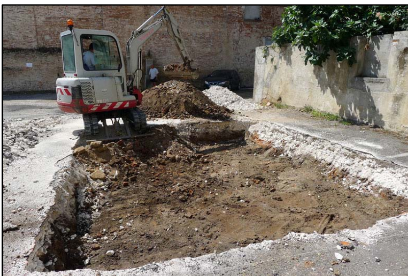
Figure 11 : Le décapage en cours d'achèvement
