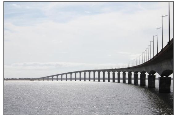
Figure 1: Ile de Ré Bridge (V. Bouteiller, Ifsttar)
