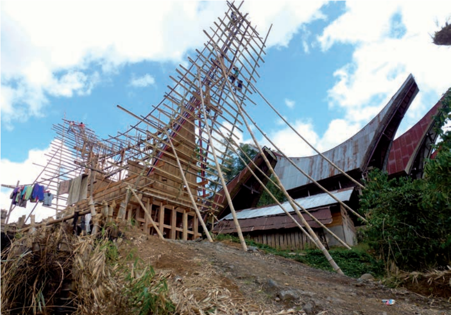
Fig.10 – Maison traditionnelle ( tongkonan ) en construction, Lempopoton, 13/11/2014. La maison tongkonan représente le lieu de fondation du rapuan , groupe de filiation cognatique orienté vers un ancêtre commun. (Cliché : D. Rappoport)
