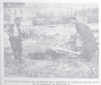
M. FILLEUX s'enquiert des conditions dans lesquelles est creusé le premier puits de la fondation du Bâtiment 3.
