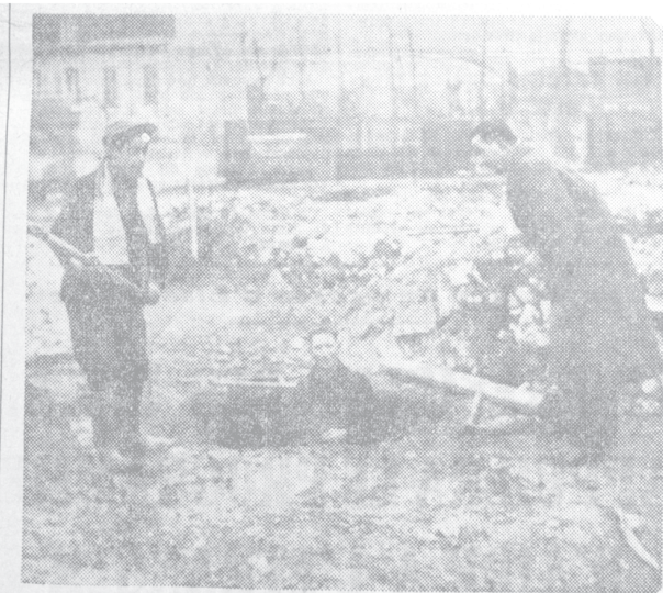
M. FILLEUX s'enquiert des conditions dans lesquelles est creusé le premier puits de la fondation du Bâtiment 3.
