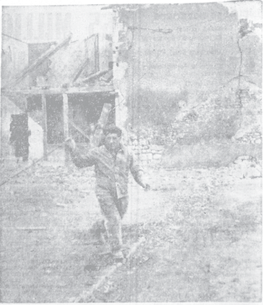
Rue du Bouffier, des ouvriers s'emploient actuellement à des travaux de démolition. Un immeuble vétuste a été abattu hier après-midi et de nombreux curieux contemplant la scène. Ce soir, généralement le plus l'assiduo, c'étaient les grands ouvriers employés par les démolisseurs. En effet, ceux-ci avaient entouré le pan de mur à abattre d'un câble dont l'extrémité était solidement attachée à un camion. Après plusieurs tentatives infructueuses, les méthodes modernes eurent raison de l'ancêtre et le mur s'effondra dans une épouvanante cascade de gravats et de poussière.
