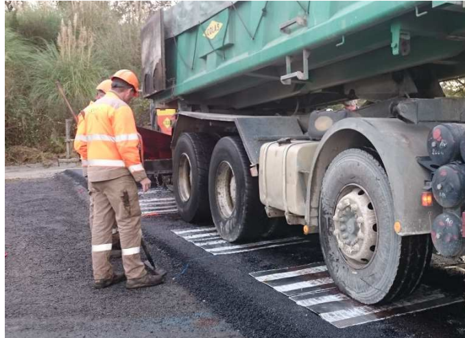
Figure 1 : Réalisation des planches expérimentales : circulation de camion sur les grilles.
