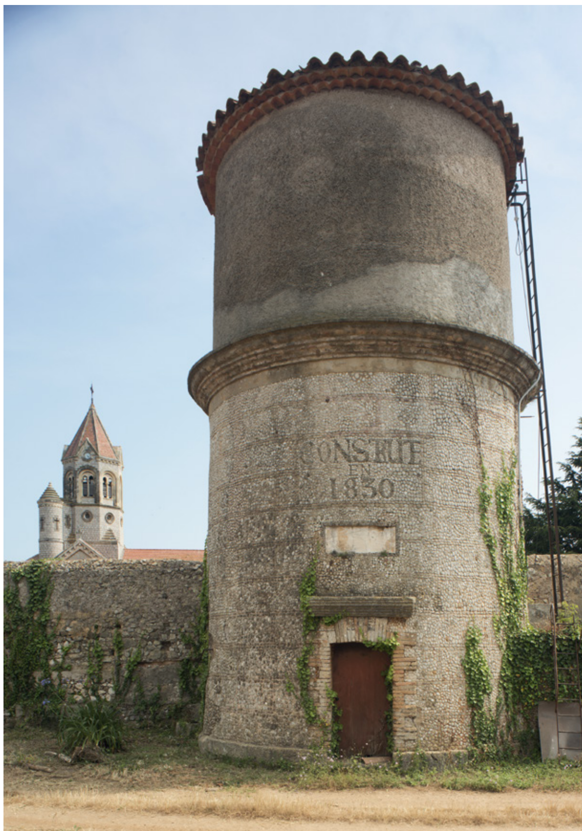
Fig. 34 Château d'eau dit de la source de Saint-Honorat avec parement en assemblage de galets, commandé et achevé en 1830 par Louis Sicard. Arch. dép. Alpes-Martimes, en cours de classement.
