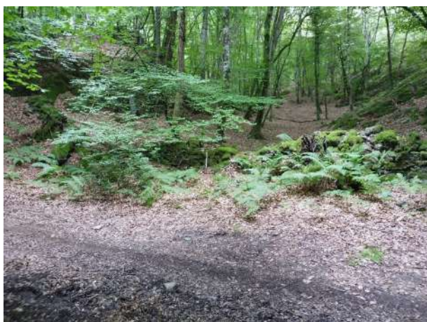
Fig. 100 : Mur de barrage à l'entrée de l'ensemble au nord
