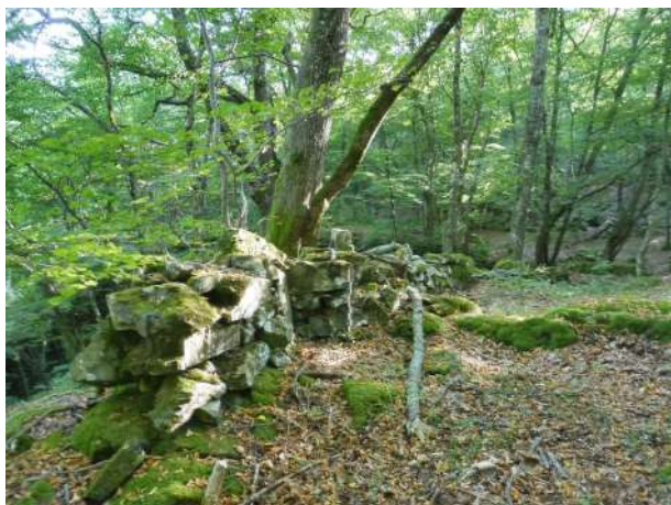
Fig. 96 : Mur de barrage fermant l'accès à l'éperon au nord du secteur 3
