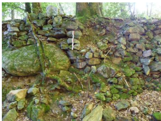
Fig. 95 : Mur de soutènement ouest de la saignée
