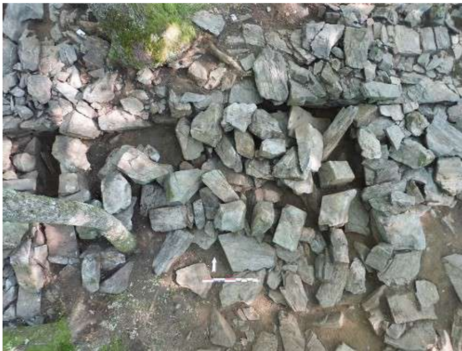
Fig. 38: Bâtiment 01 – Vue zénithale de SB105 sans la couverture – US059 et US062
