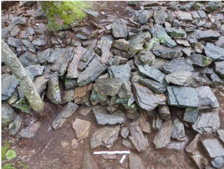
Fig. 37: Bâtiment 01 – Vue zénithale de la couverture 006 de SB105
