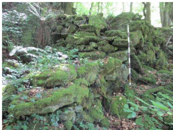
Fig. 111 : Mur défensif surplombant le chemin d'accès
