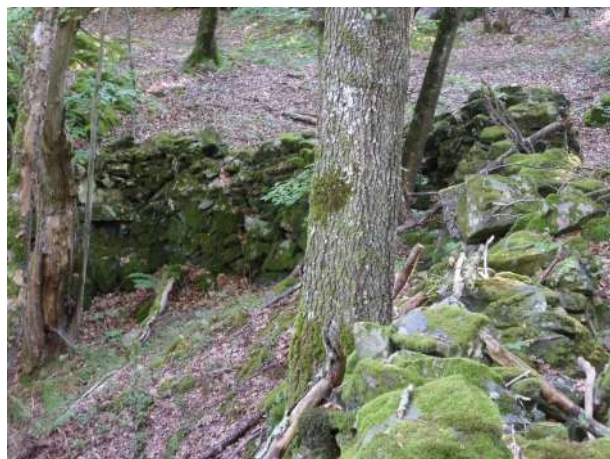
Fig. 97 : Mur de barrage fermant l'accès à l'éperon au nord du secteur 3
