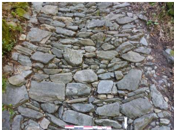
Fig. 93: Détail de la mise en œuvre du chemin
