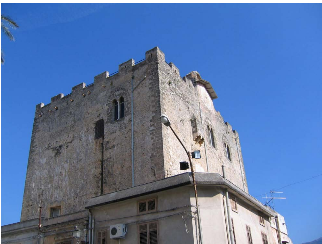
Fig. 2 La torre dei Ventimiglia, sede del Museo Civico di Montelepre
