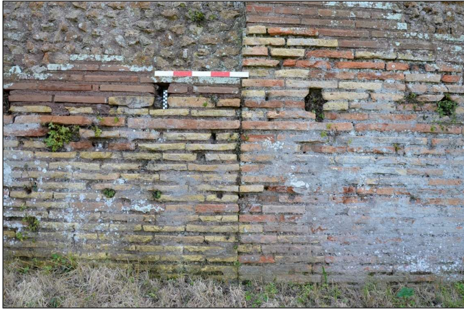
Fig. 13. A sinistra tamponatura di porta di cantiere (foto M. Turci)
