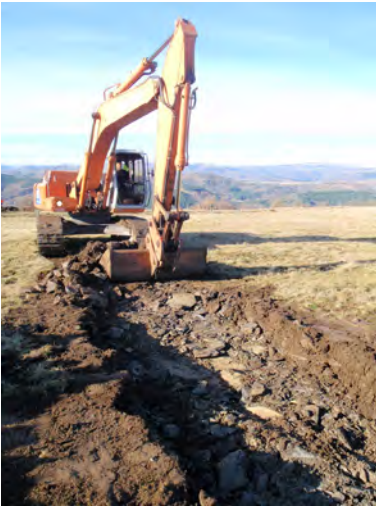
Fig. 4 - Réalisation d'une tranchée sur le plateau d'Espalem © M. Gandelin, Inrap
