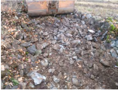
Fig. 13 - Réalisation de la tranchée 15 dans le tertre 1 – évacuation des niveaux supérieurs de tas d'épierrement. © M. Gandelin, Inrap
