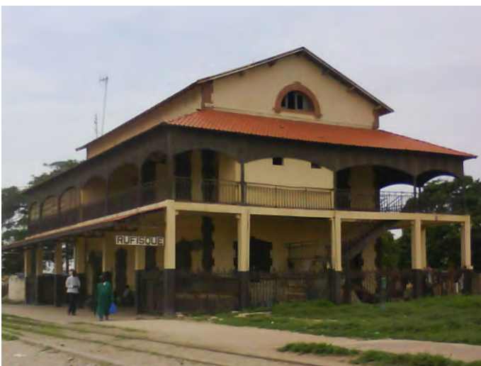
Ancienne gare de Rufisque. La construction est dotée de larges espaces périphériques ouverts sur deux niveaux qui protègent les façades.
