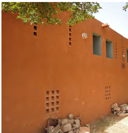
Mur double ventilé, école bioclimatique à Dagana Agence Terreneuve architecte
