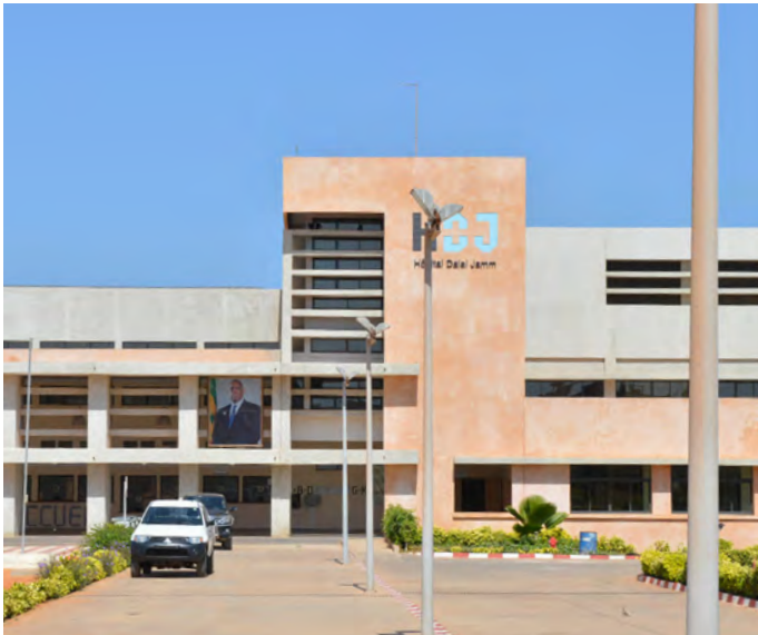
Hopital Dalal Jamm, Dakar. Le bâtiment adopte de nombreuses dispositions bioclimatiques afin de limiter les consommations de climatisation.
