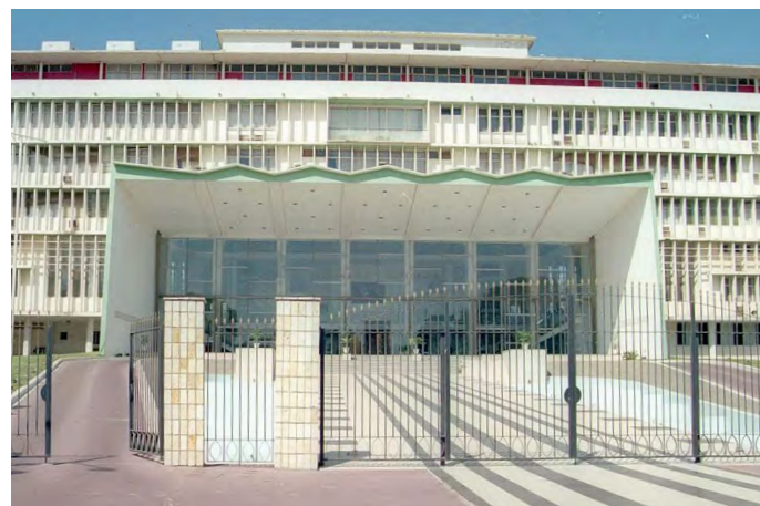
Façade à brises soleil - Assemblée Nationale, Dakar PNEEB typha
