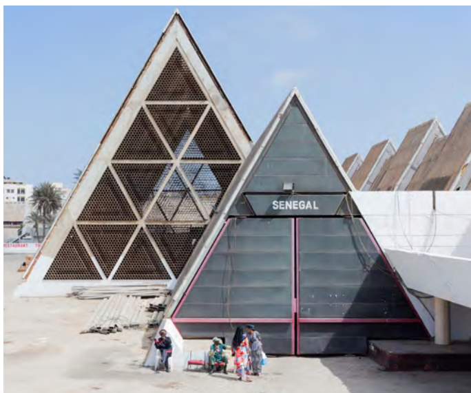
Palais des expositions de Dakar - Cices (Centre international du commerce extérieur). Parois ajourées permettant une ventilation traversante PNEEB typha
