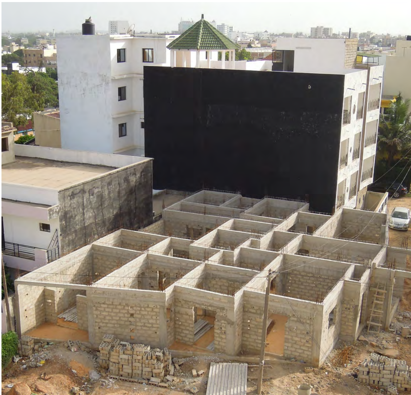
Une erreur courante, étancher la surface des murs pignons avec du bitume, ce qui augmente considérablement l'absorption d'énergie du rayonnement solaire
