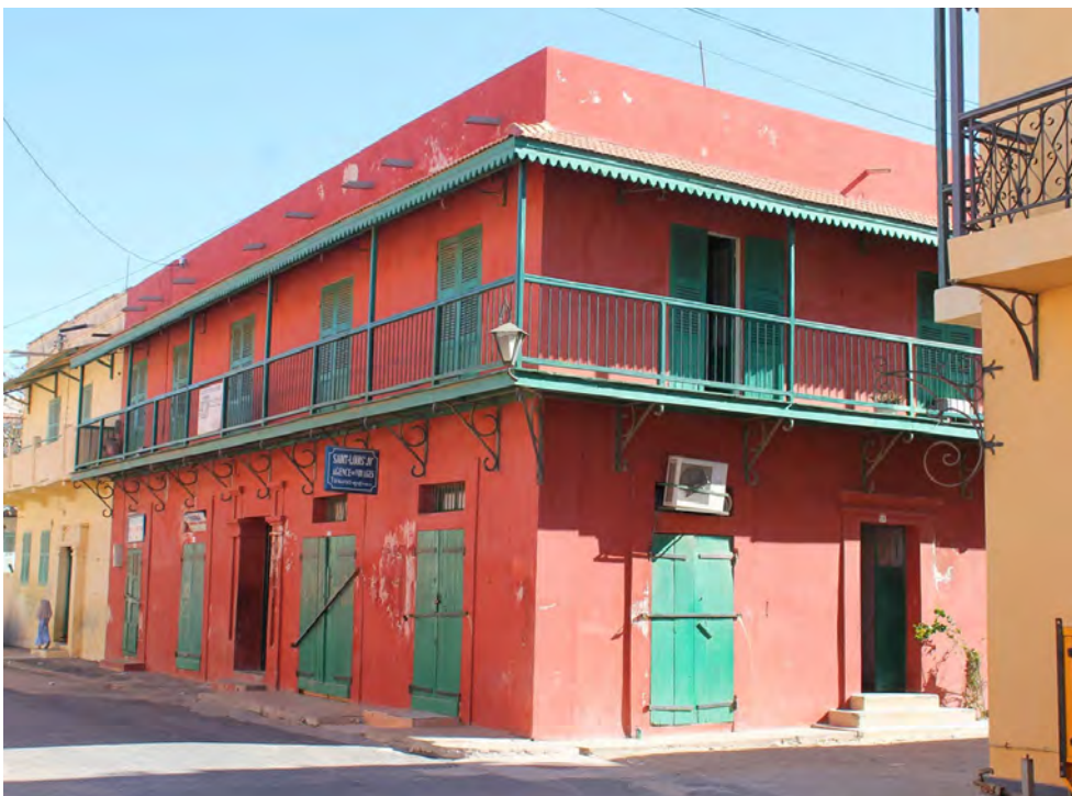
Saint-Louis. : balcons, galeries, volets persiennés, et même compactité et mitoyenneté des constructions constituent autant de systèmes de protections solaires. Pheeb-Typha
