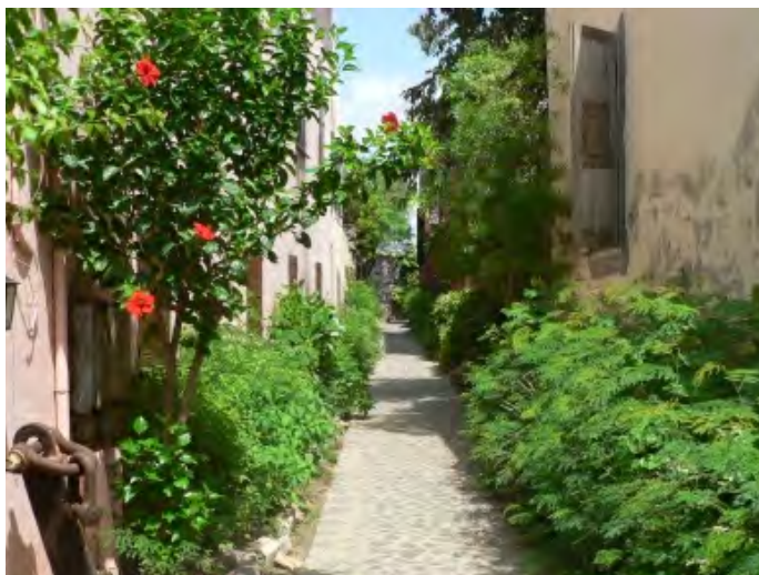
Végétation protégeant les murs, île de Gorée
