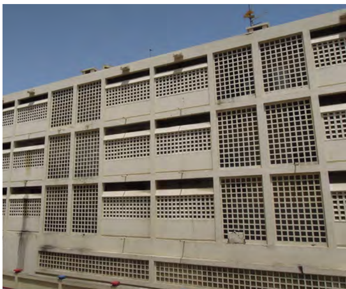
Façade à claustras
