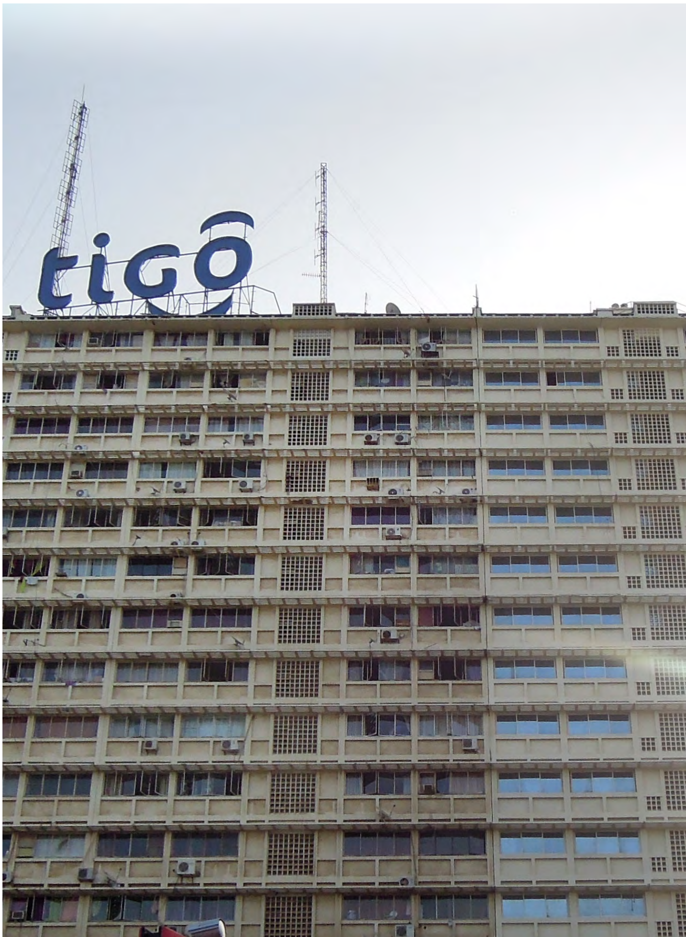
Immeuble d'habitation à Dakar. Les blocs des climatiseurs envahissent les façades.
