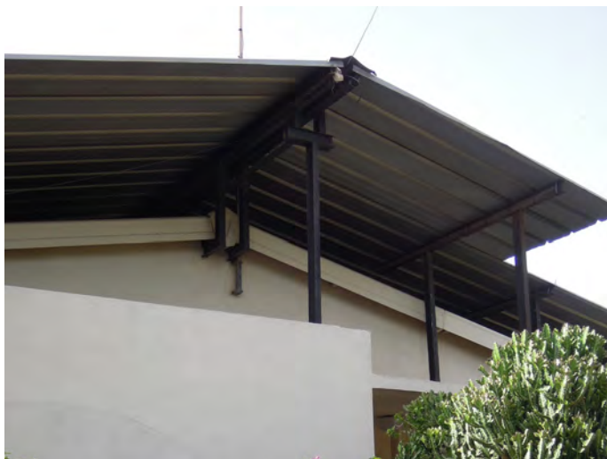
Sur-toiture ventilée - Dakar Atelier d'architecture MBN
