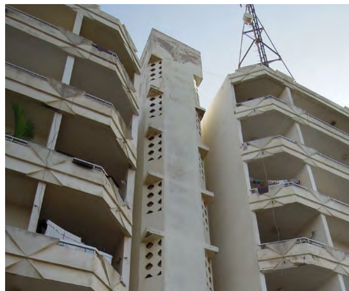
Parois des communs équipées de claustras permettant une ventilation naturelle performante
