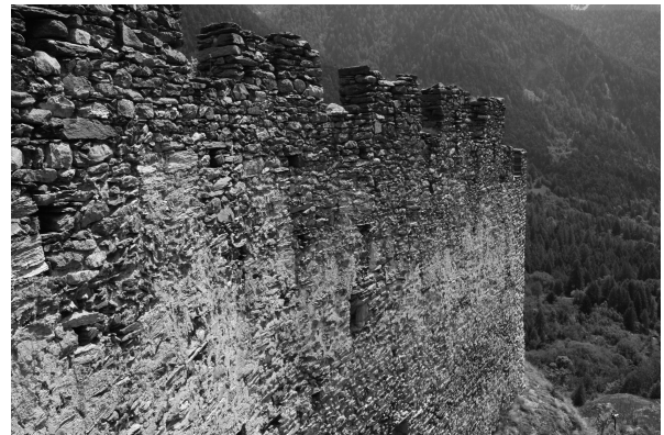
Figure 18 : Parement extérieur de l'enceinte du château de Graines. Cliché : G. Sartorio, RAVA.
