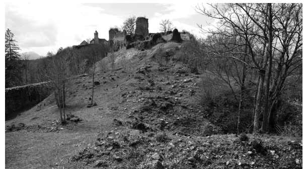
Figure 19 : Château-Vieux d'Allinges, anomalies topographiques indiquant la présence de bâtiments enfouis dans le bourg castral. Cliché : L. D'Agostino, Hadès.
