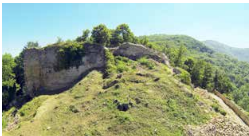
fig. 4 Bâtiments résidentiels du château de Saint-Germain en 2013 ; de gauche à droite, la tour de la chapelle fouillée dans les années 1970, le logis et la tour maîtresse. On estime à 200 m 3 le volume de gravats recouvrant la tour
