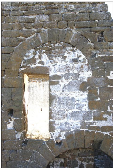
**Fig. 38** : Baie (OUV 131) de l'étage du logis roman sur la façade nord, bouchée et transformée en porte à la fin du Moyen Âge. Cliché : L. D'Agostino, 2007.
