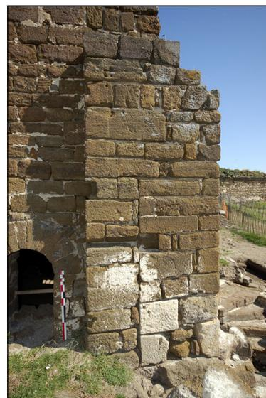
Fig. 82 : Encoche destinée à recevoir le linteau de la porte POR 75 creusée dans le contrefort CTF 76. Cliché : L. D'Agostino, 2007.
