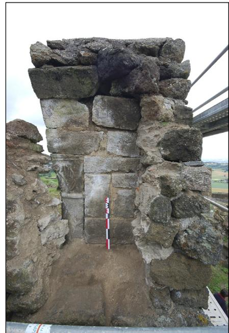
**Fig. 57** : Colonne PIL 55 et tableau de la niche romane bouchée par la mur de refend M 7. Cliché : L. D'Agostino, 2007.
