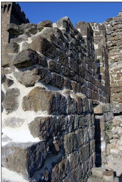
**Fig. 33** : Parement interne de la façade nord du logis roman (M 12) et ressaut de plancher. Cliché : L. D'Agostino, 2007.
