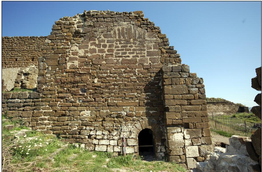
Fig. 52 : Logis roman : extrémité est de la façade sud : porte (POR 37) au rez-de-chaussée et baies à l'étage (FEN 41 et BAI 42) . Cliché : L. D'Agostino, 2007.
