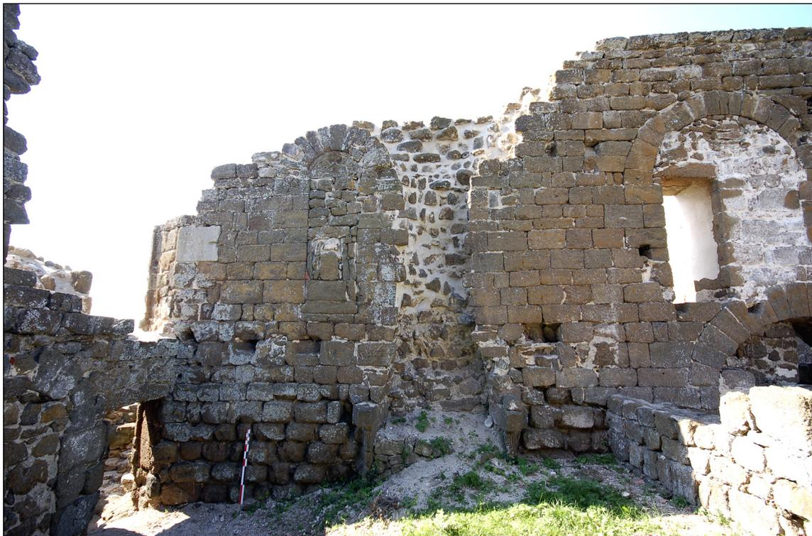
**Fig. 45** : Façade nord du logis roman : trous de poutres et cheminée aménagés à la fin du Moyen Âge lors de la construction du bâtiment nord (Secteur 3). Cliché : L. D'Agostino, 2007.
