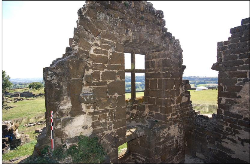
**Fig. 55** : Partie ouest de la galerie d'arcatures de la façade sud, perturbée par le percement de croisées à la fin du Moyen Âge. Cliché : L. D'Agostino, 2007.
