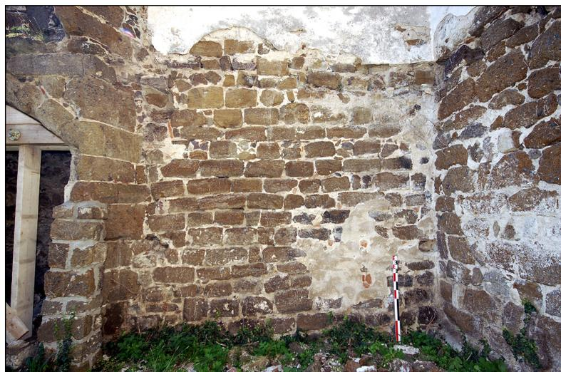
Fig. 69 : Parement nord roman du refend M 5/M 9 et trous de poutres bouchés. Cliché : L. D'Agostino, 2007.
