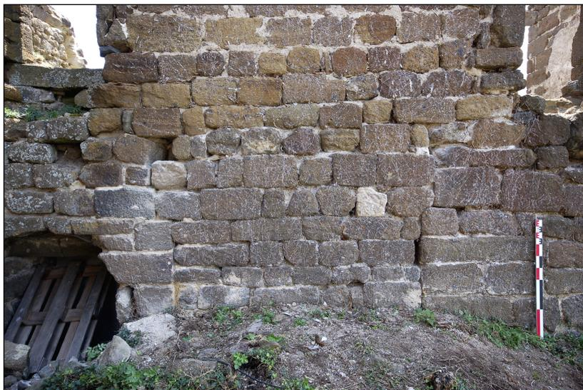
Fig. 67 : Portail bouché et parement roman en partie basse de M 5/M 9.
