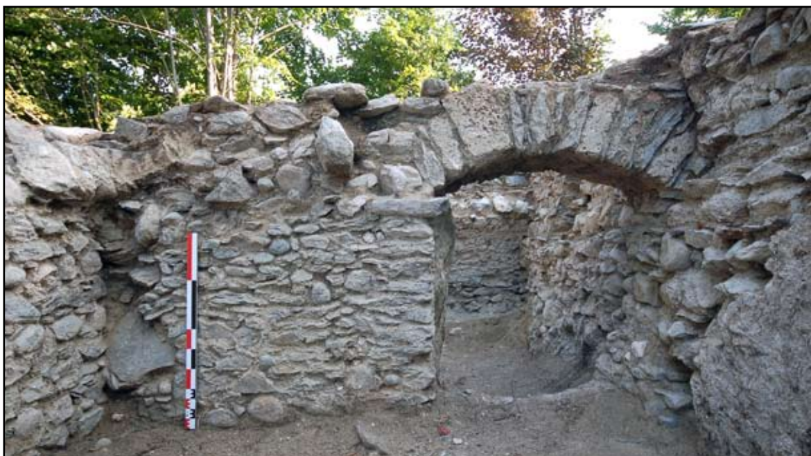
Le Châtelet, Bâtiment 1, porte de communication entre les deux caves.
