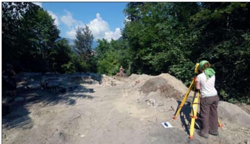
Fig. 28 : Relevé des structures au tachéomètre. Cliché : L. D'Agostino, SDAHS 2008.
