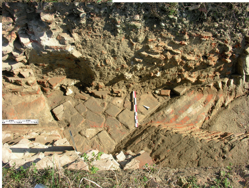
FIG. 70 - Zone 6. Détail de la voûte (VUT 08) éventrée au premier plan. Cliché de L. D'AGOSTINO, Hadès, 2005
