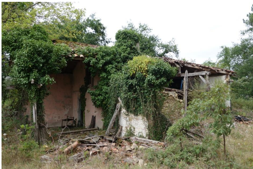
Fig. 89. Exemple d'une maison abandonnée, gîte de l'Effraie des clochers
