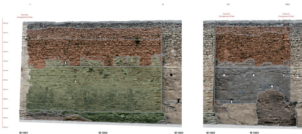
Remparts d'Alixan (Drôme) : phases de construction sur fond d'orthoimages
