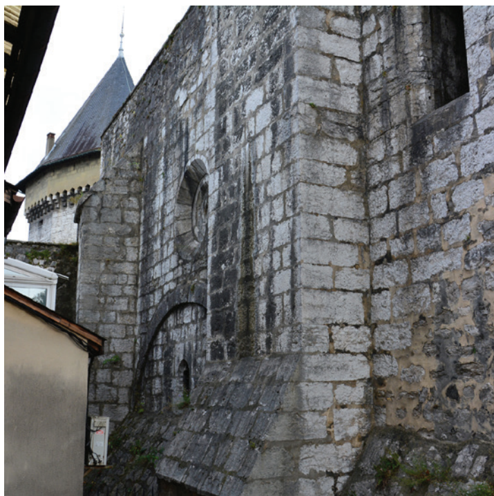
Fig. 52 : Vue d'ensemble de l'emprise de la salle orientale sur la courtine nord du château, entre deux contreforts. Cliché : E. Chauvin-Desfleurs.
