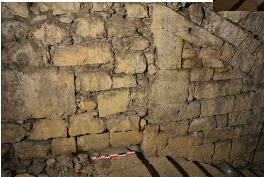
Fig. 29 : Césure entre le mur sud de la volée inférieure de l'escalier et les murs périphériques du palier intermédiaire ; première assise du palier formant feuillure en retrait du parement. Cliché : E. Chauvin-Desfleurs.
