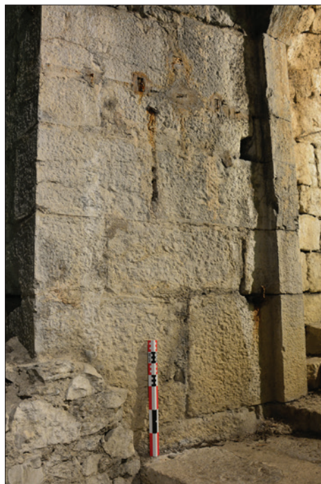
Fig. 34 : Tableau nord de la porte. Cliché : E. Chauvin-Desfleurs.
