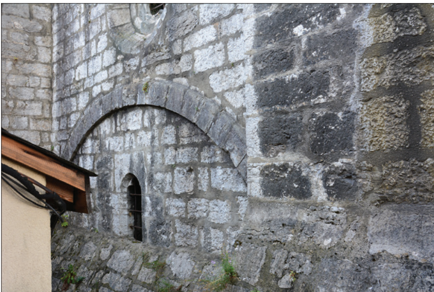
Fig. 51 : Détail de la maçonnerie construite en sous-œuvre de la grande arcade nord sur le parement nord de la courtine. Cliché : E. Chauvin-Desfleurs.
