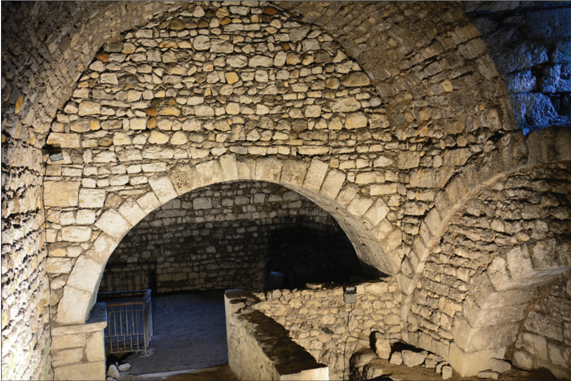
Fig. 44 : Détail du mur ouest et de la grande arcade séparant les deux salles et chaînage avec le mur nord de la salle orientale. Cliché : E. Chauvin-Desfleurs.
