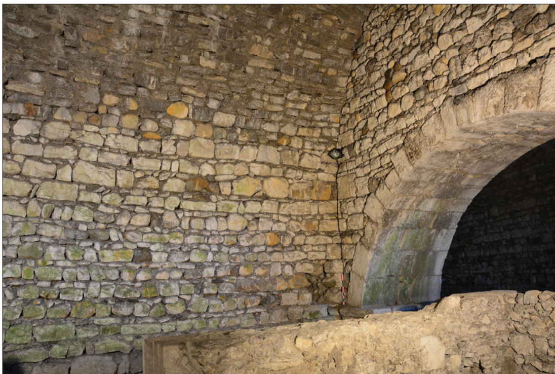
Fig. 39 : Détail du mur sud de la salle orientale et du chaînage avec le mur ouest. Cliché : E. Chauvin-Desfleurs.
