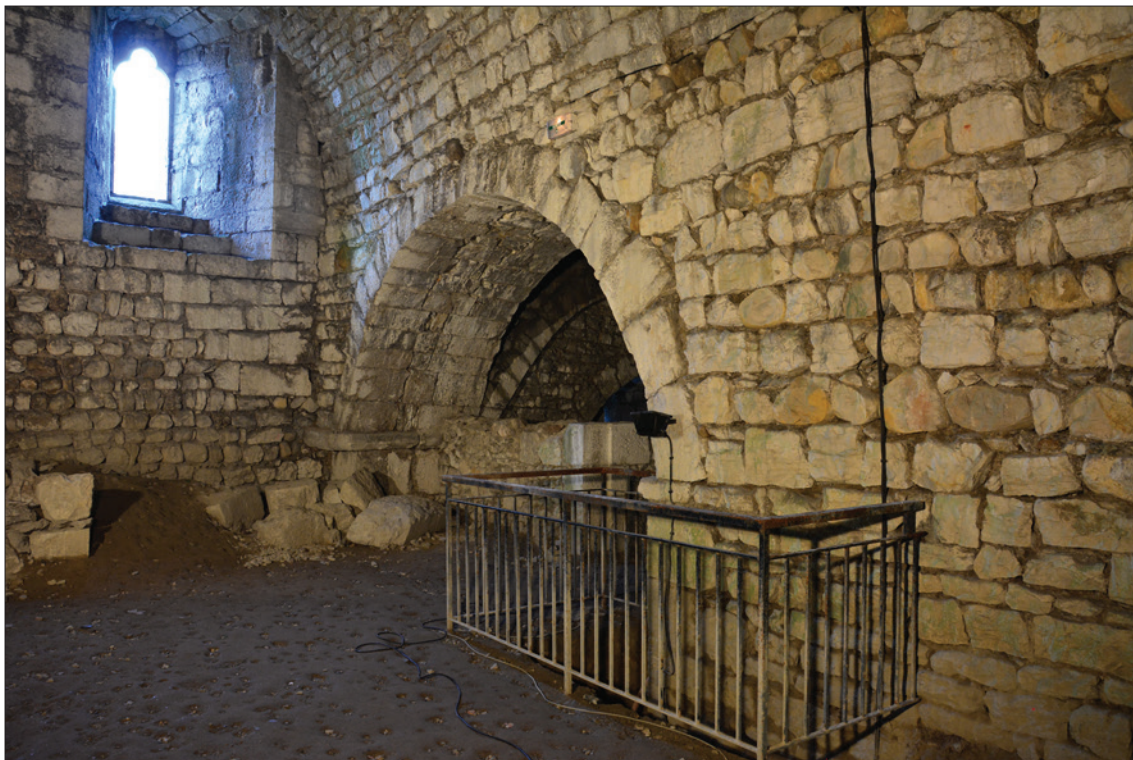
Fig. 64 : Correspondance des assises entre le pilastre sud et le mur est de la salle occidentale. Cliché : E. Chauvin-Desfleurs.
