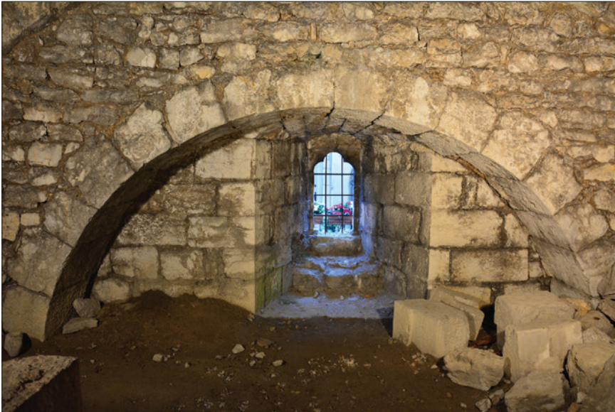
Fig. 50 : Deuxième arcade en sous-œuvre de la grande arcade nord et baie trilobée. Cliché : E. Chauvin-Desfleurs.
