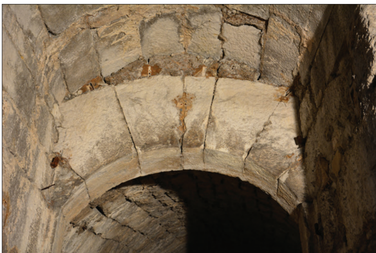
Fig. 35 : Arrière-voussure et extrados de l'arc de la porte. Cliché : E. Chauvin-Desfleurs.
