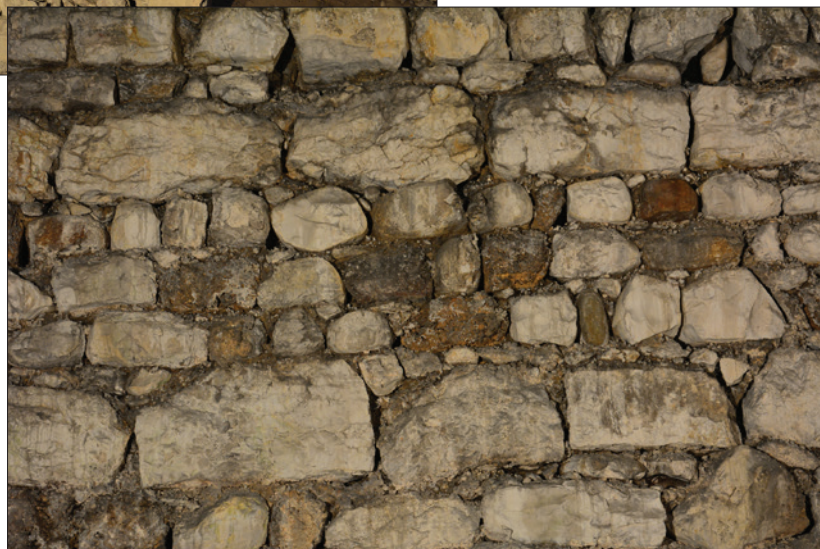
Fig. 61 : Détail du parement du mur ouest : blocs bruts ou grossièrement équarris de calcaire et de tuf, alternance d'une assise haute et deux à quatre assises basses. Cliché : E. Chauvin-Desfleurs.
