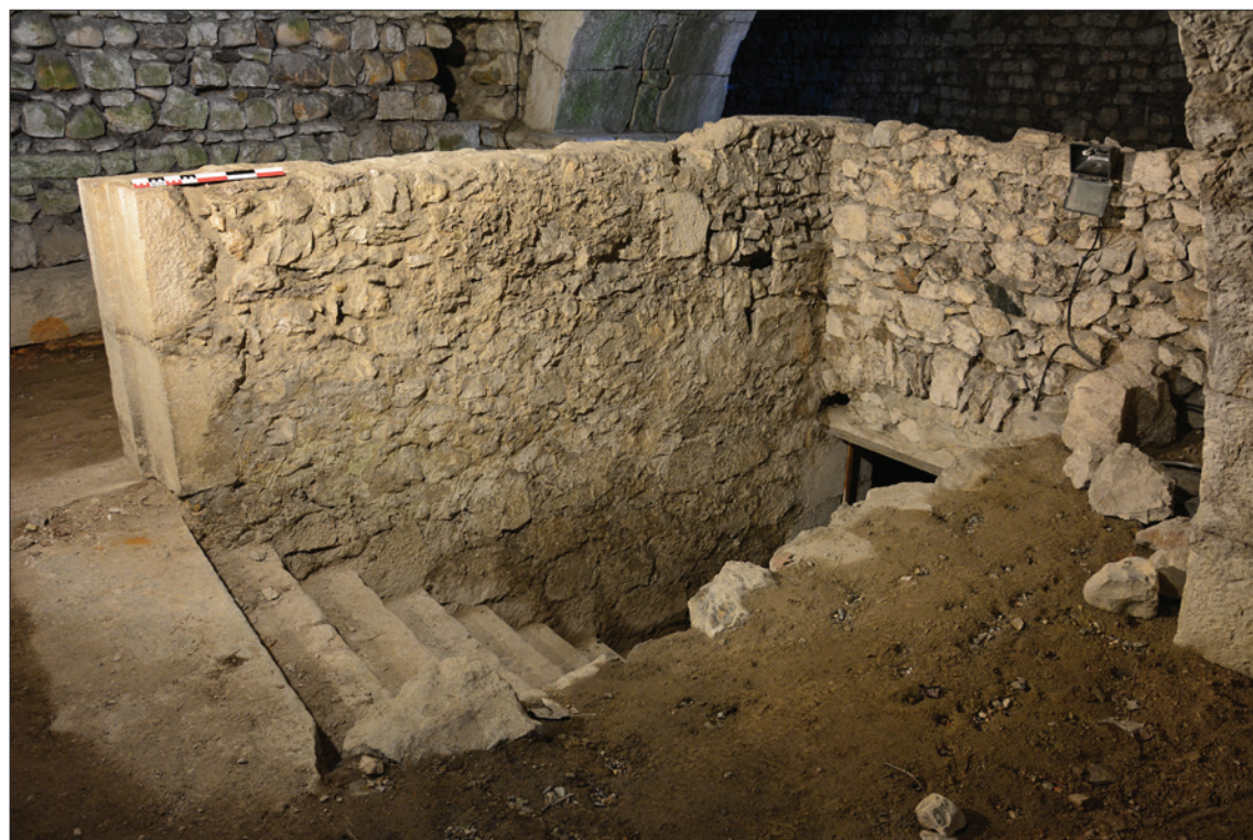
Fig. 57 : Escalier d'accès à la cave du deuxième sous-sol. Cliché : E. Chauvin-Desfleurs.
