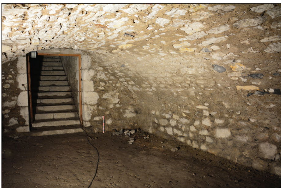
Fig. 72 : Murs sud et est de la cave, noyés dans le mortier. Cliché : L. D'Agostino.
