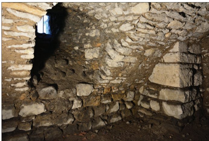
Fig. 75 : Soupirail percé dans le mur nord de la cave et contemporain de la voûte. Cliché : L. D'Agostino.
