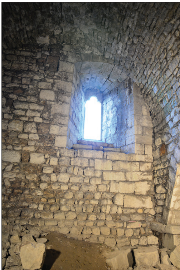
Fig. 65 : Reconstruction en moyen appareil de calcaire autour de la baie en lancette du mur nord. Cliché : E. Chauvin-Desfleurs.
