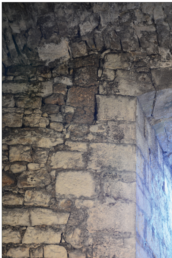
Fig. 66 : Détail du vestige de piédroit ouest d'un ancien aménagement en tuf dans le mur nord. Cliché : E. Chauvin-Desfleurs.
