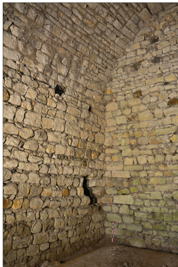
Fig. 63 : Chaînage et correspondances d'assises entre les murs sud et est de la salle occidentale. Cliché : E. Chauvin-Desfleurs.
