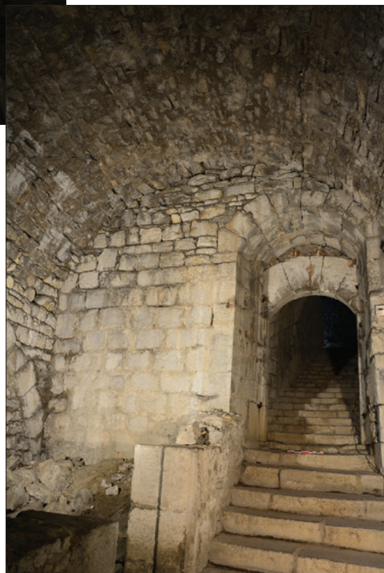
Fig. 53 : Mur est de la salle orientale et escalier droit ; détail de la voûte. Cliché : E. Chauvin-Desfleurs.
