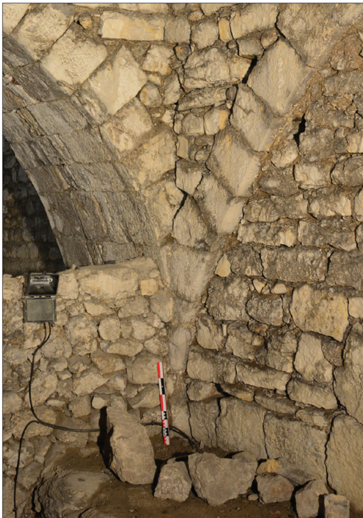
Fig. 46 : Pilastre et sommier accueillant les grandes arcades ouest et nord ; le pilastre est en partie noyé dans une maçonnerie postérieure. Cliché : E. Chauvin-Desfleurs.
