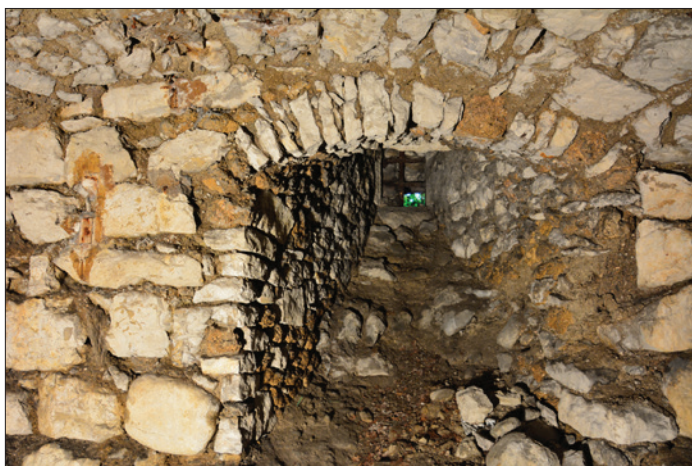
Fig. 76 : Soupirail percé dans le mur ouest de la cave ; le jour est bouché par le glacis construit sur sa face externe. Cliché : L. D'Agostino.
