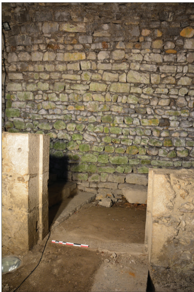
Fig. 56 : Détail du piédroit nord et du seuil de la porte aménagée dans le refend ouest, en sous-œuvre de la grande arcade séparant les deux salles. Cliché : E. Chauvin-Desfleurs.
