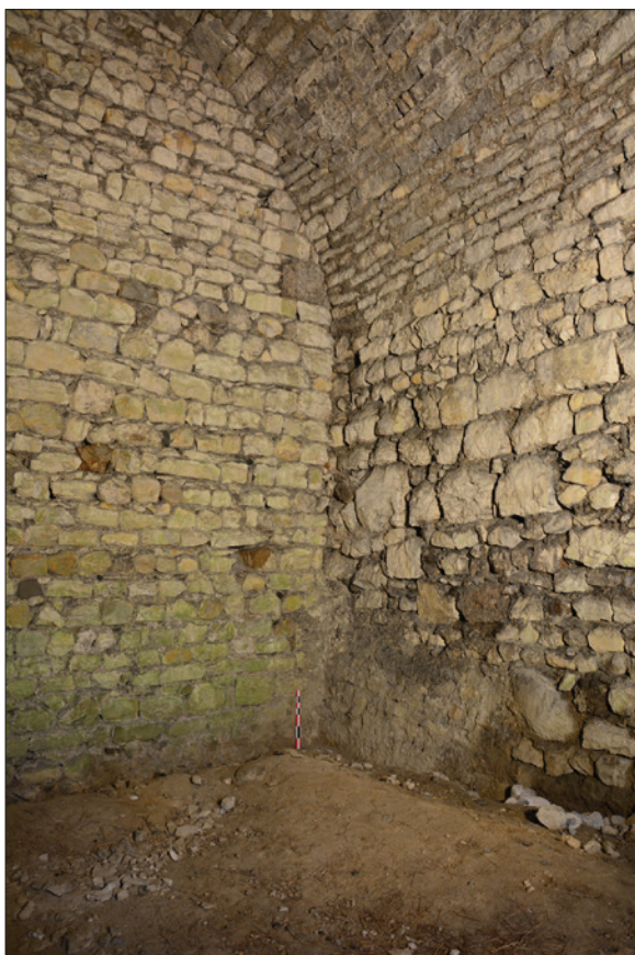
Fig. 63 : Chaînage et correspondances d'assises entre les murs sud et est de la salle occidentale. Cliché : E. Chauvin-Desfleurs.
