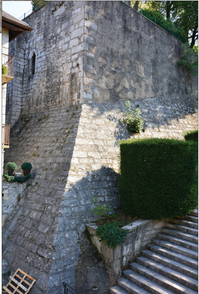
Fig. 80 : Angle nord-ouest de l'enceinte castrale. Cliché : E. Chauvin-Desfleurs.
