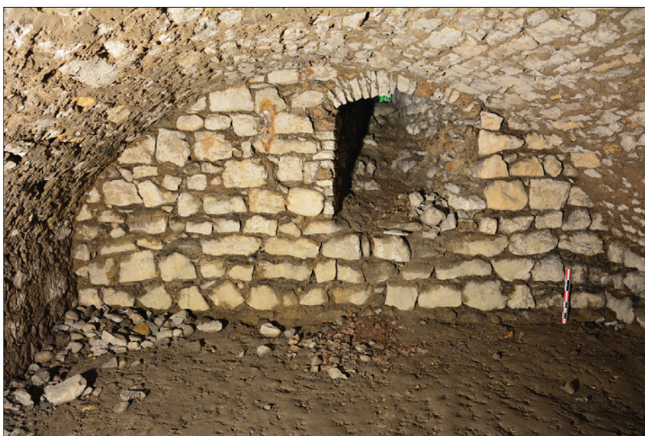
Fig. 71 : Mur ouest de la cave, parement en blocs bruts ou grossièrement équarris de calcaire, assises réglées. Cliché : L. D'Agostino.
