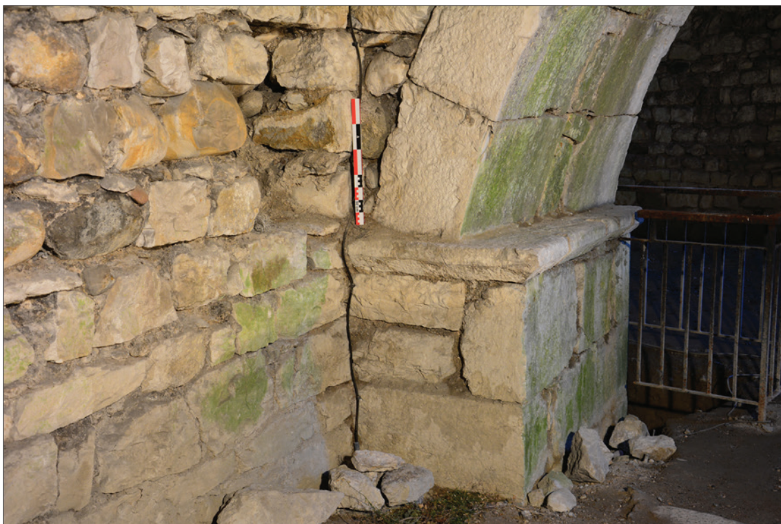
Fig. 42 : Chaînage entre le pilastre sud et le mur sud de la salle orientale. Cliché : E. Chauvin-Desfleurs.
