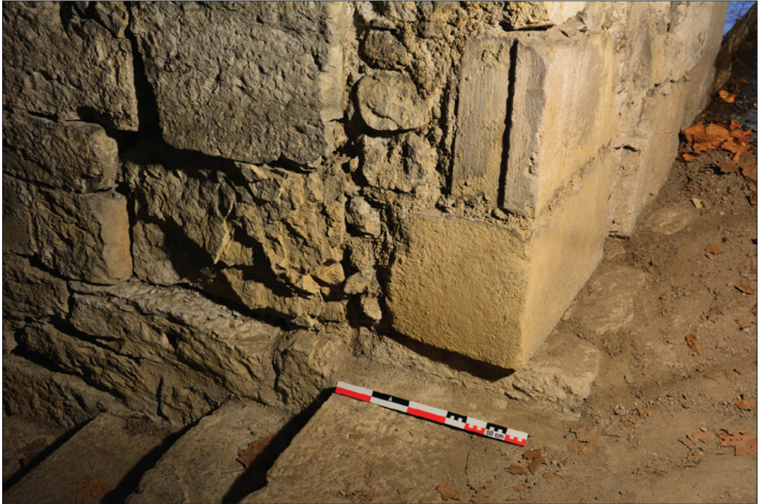
Fig. 30 : Vestige de maçonnerie formant feuillure au débouché de la volée inférieure de l'escalier à la base du parement nord. Cliché : E. Chauvin-Desfleurs.
