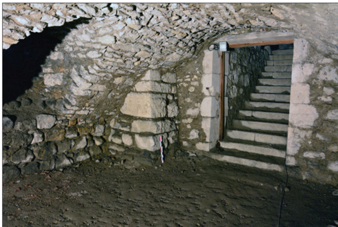
Fig. 73 : Base du pilastre nord en appui sur le parement du mur nord et mur de la cave qui vient chemiser le pilastre. Cliché : L. D'Agostino.
