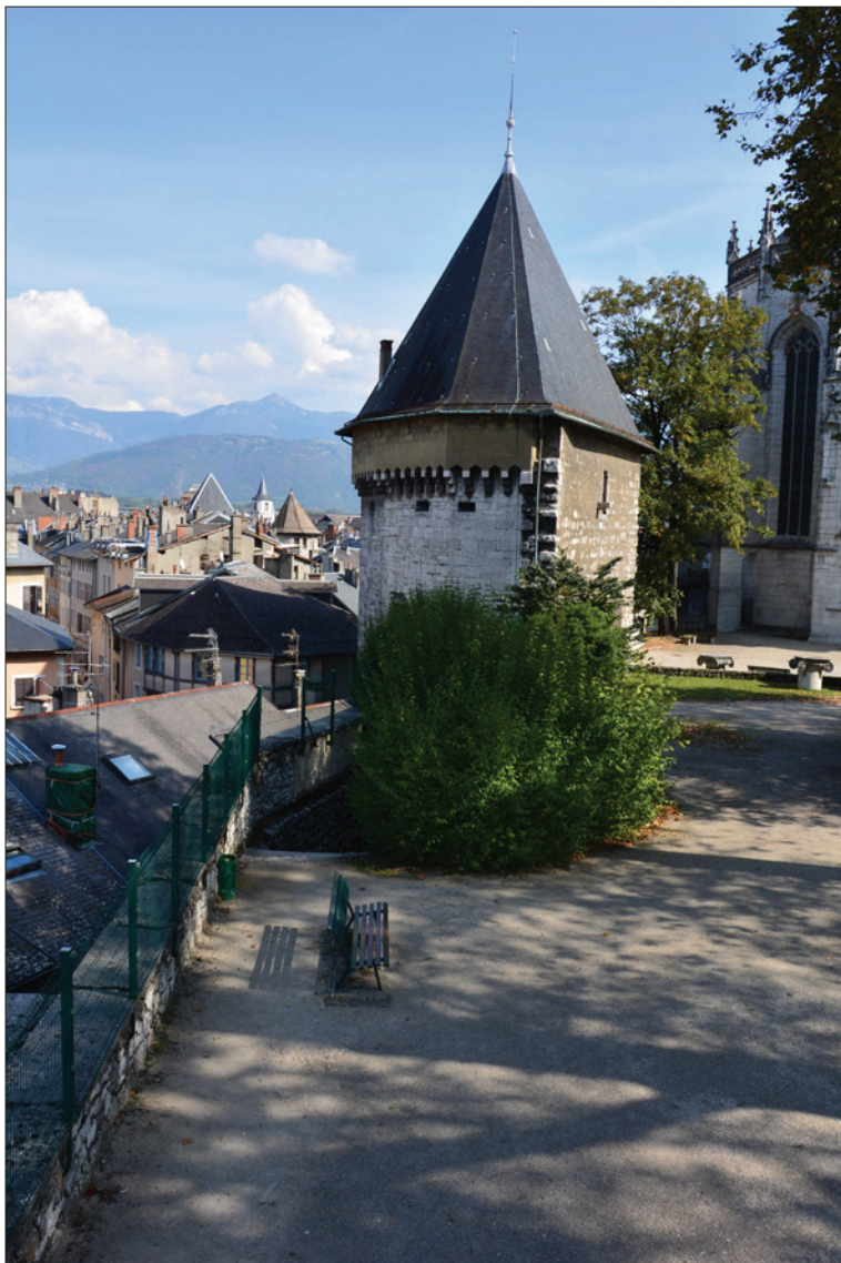
Fig. 21 : Emplacement de l'escalier d'accès des Salles basses, le long de la courtine nord du château. Cliché : E. Chauvin-Desfleurs.
