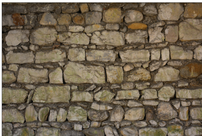
Fig. 40 : Détail de l'appareil du mur sud : blocs bruts ou grossièrement équarris disposés en assises réglées et nombreuses cales. Cliché : E. Chauvin-Desfleurs.
