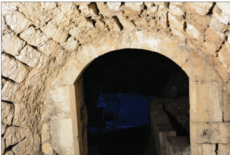
Fig. 33 : Partie haute de la porte, avec piédroits à chanfreins et arc surbaissé sans chanfrein. Cliché : E. Chauvin-Desfleurs.
