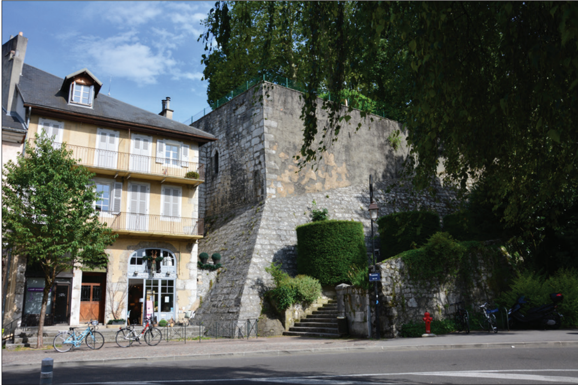
Fig. 19 : L'angle nord-ouest de l'enceinte du château de Chambéry aujourd'hui et l'emplacement des Salles basses du Vieux Pavillon. Cliché : L. D'Agostino.
