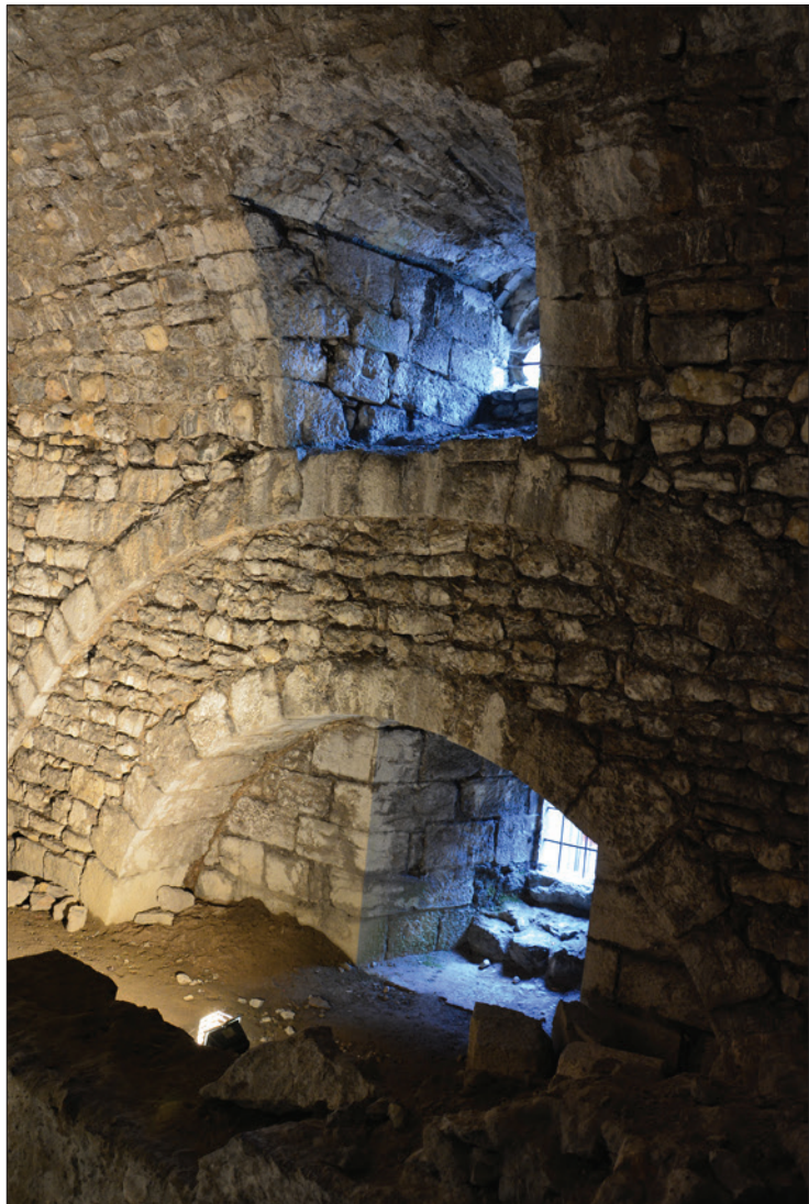
Fig. 44 : Détail du mur ouest et de la grande arcade séparant les deux salles et chaînage avec le mur nord de la salle orientale. Cliché : E. Chauvin-Desfleurs.
