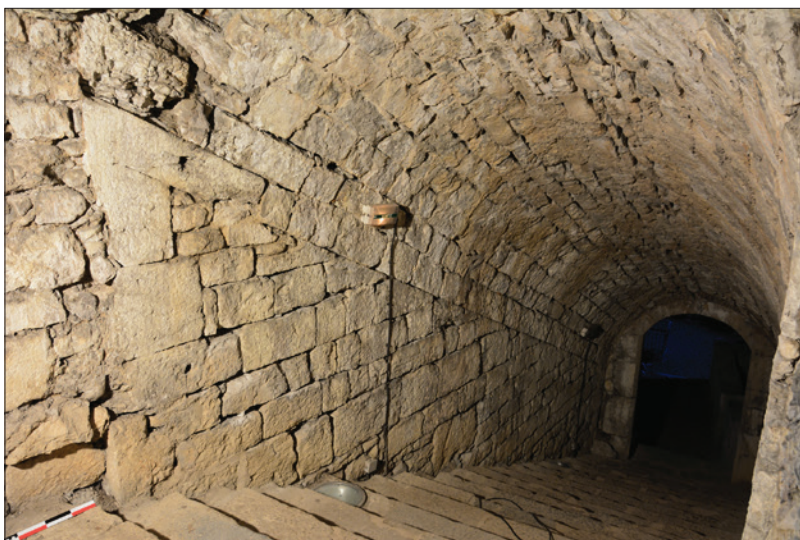
Fig. 25 : Volée inférieure de l'escalier d'accès aux Salles basses. Cliché : E. Chauvin-Desfleurs.
