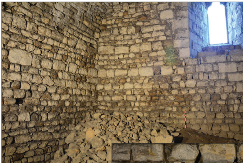
Fig. 60 : Chaînage d'angle des murs nord et ouest de la salle occidentale. Cliché : E. Chauvin-Desfleurs.
