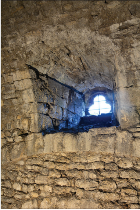
Fig. 49 : Oculus trilobé et grande arcade nord de la salle orientale sur le parement nord de la courtine. Cliché : E. Chauvin-Desfleurs.
