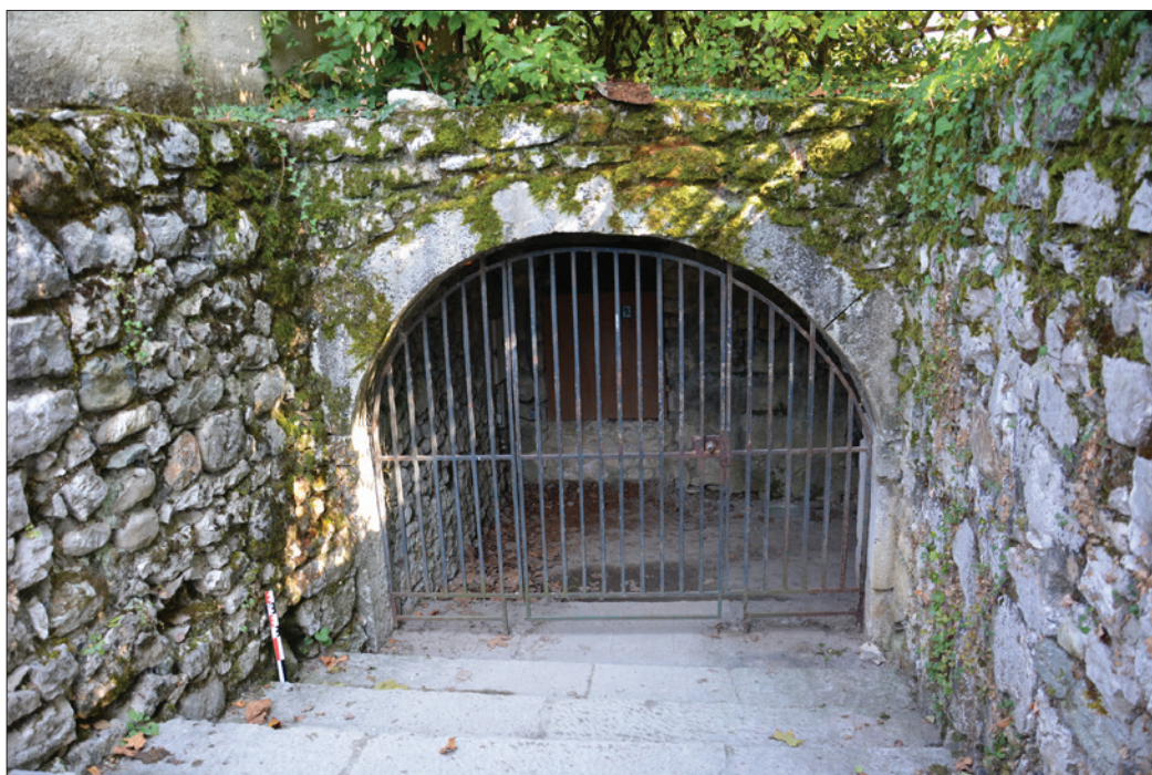
Fig. 22 : Première volée de l'escalier d'accès et portail fermant les Salles basses. Cliché : L. D'Agostino.
