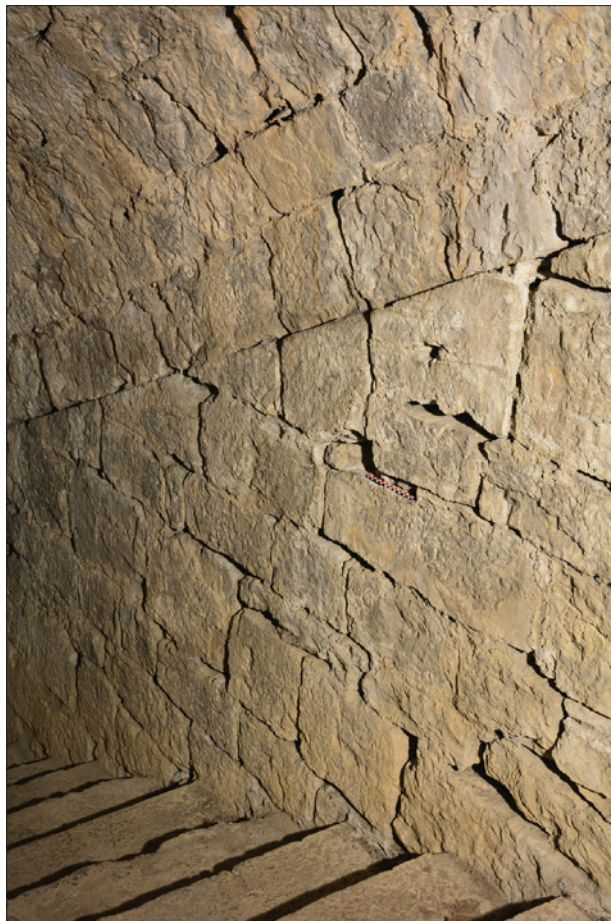
Fig. 26 : Détail du parement du mur d'échiffre nord de l'escalier. Cliché : E. Chauvin-Desfleurs.
