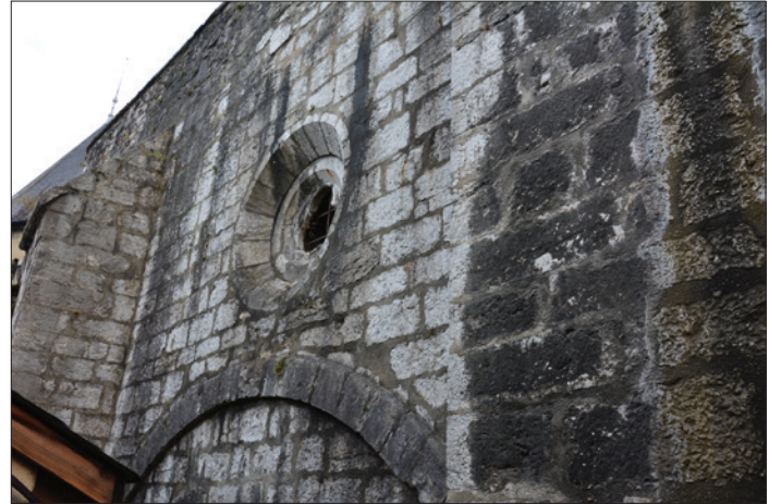
Fig. 49 : Oculus trilobé et grande arcade nord de la salle orientale sur le parement nord de la courtine. Cliché : E. Chauvin-Desfleurs.
