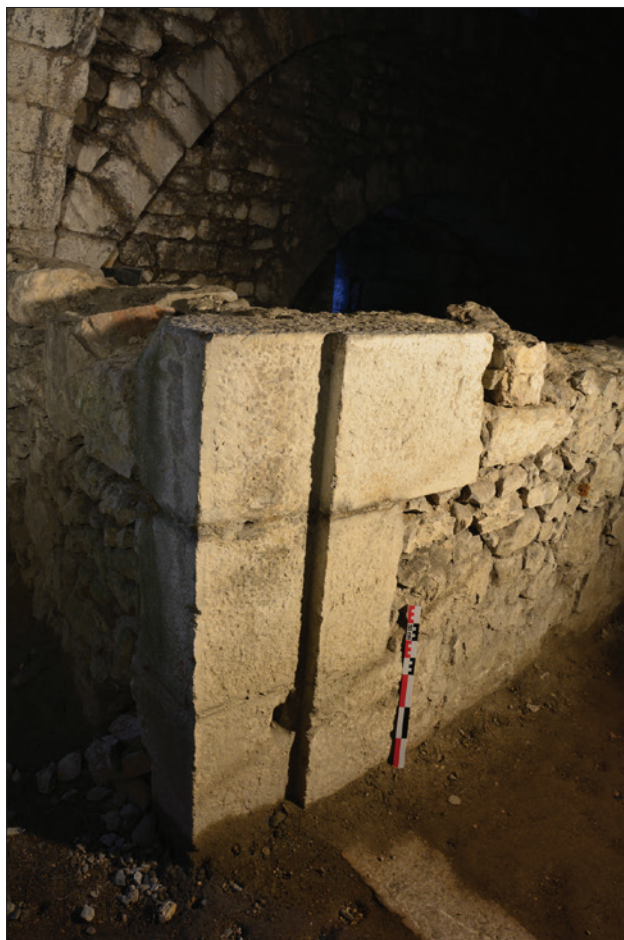
Fig. 56 : Détail du piédroit nord et du seuil de la porte aménagée dans le refend ouest, en sous-œuvre de la grande arcade séparant les deux salles. Cliché : E. Chauvin-Desfleurs.
