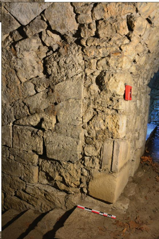
Fig. 28 : Césure entre le piédroit nord de la volée inférieure de l'escalier et le mur ouest du palier intermédiaire. Cliché : E. Chauvin-Desfleurs.
