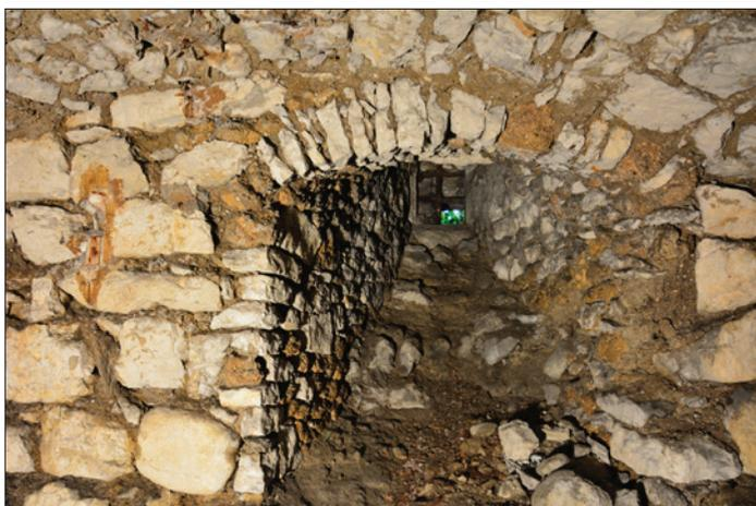
Un vestige de piédroit en tuf correspondant vraisemblablement à une ancienne ouverture ou à un aménagement intra mural (placard, latrines, cheminée...) est observable en partie haute du mur nord (**fig. 66**), sans qu'il soit possible d'associer les traces d'un niveau de sol à cette ouverture.
