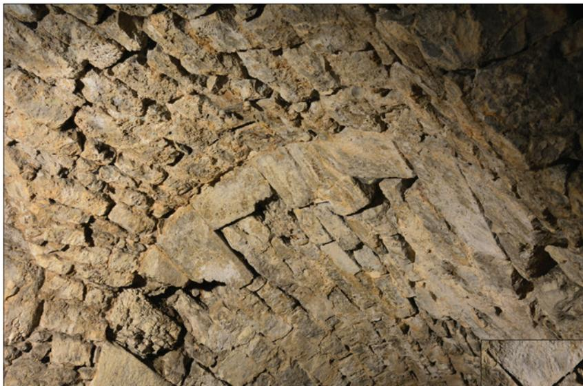
Fig. 27 : Césure entre la voûte du palier et celle de la volée inférieure de l'escalier. Cliché : E. Chauvin-Desfleurs.
