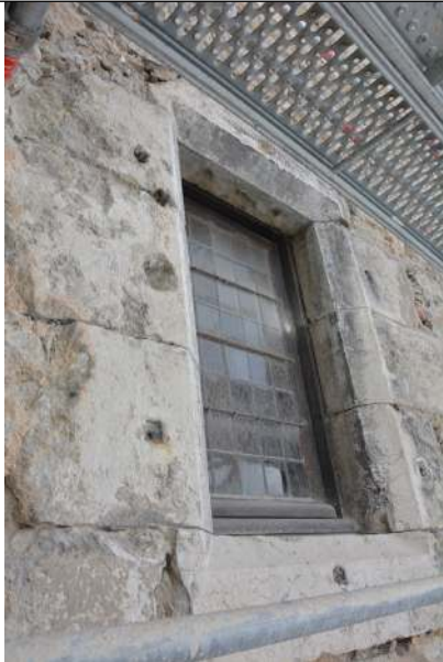
Fenêtre UC 29.02 du mur nord, trous d'ancrage de plusieurs grilles
