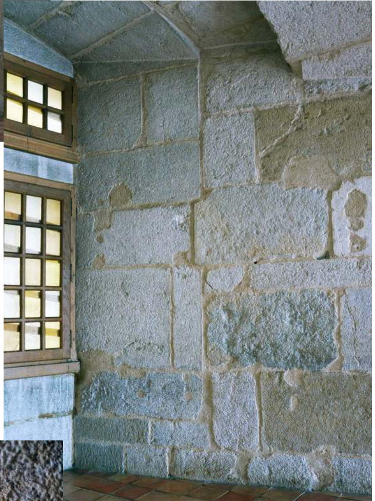
Traces de boucharde. Ici les traces sont plus fraîches et sont dues à la restauration des années 1958-1960 : elles recouvrent toute la surface des moellons, y compris les arêtes, qui sont ciselées sur les moellons taillés au XVI e siècle.
