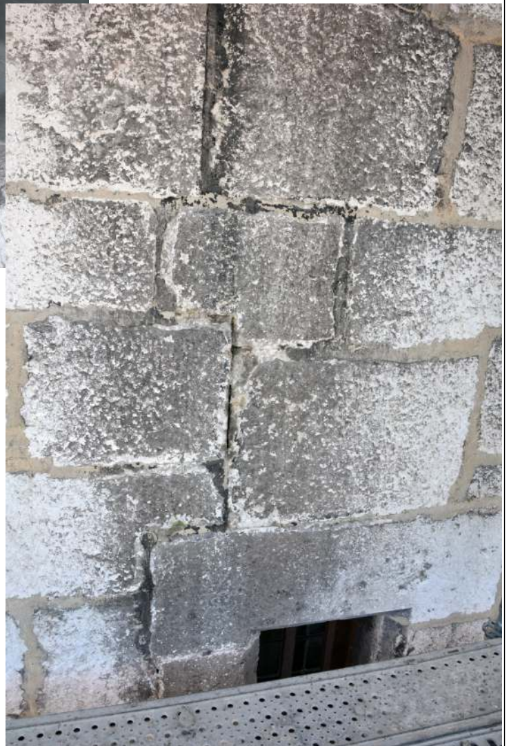
Système de harpage vertical au centre de la façade nord (M33)
