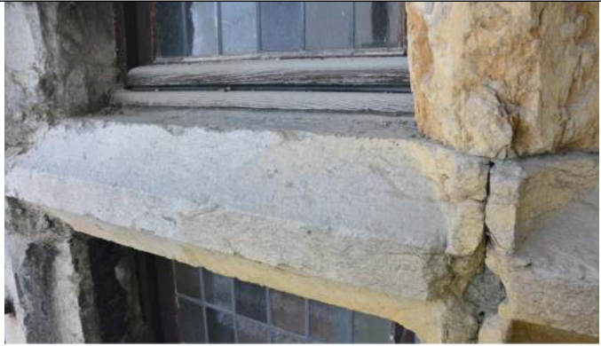
Calcaire beige-jaune et trou d'ancrage de grille
