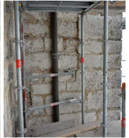
Jour d'angle UC 32.02, agrandi en porte (UC 32.04) et rebouchage en restauration (UC 32.05) : seuls le piédroit oriental et le linteau du jour d'origine sont conservés.
