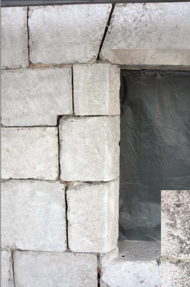
Assemblages des moellons au niveau de la fenêtre UC 33.04
