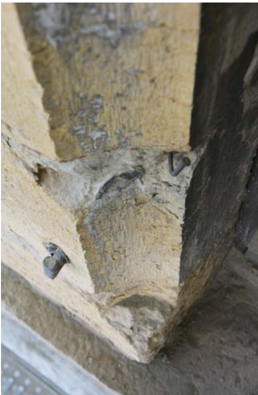
Décor de gorge et dégradation du calcaire Dégradation du congé du piédroit nord
