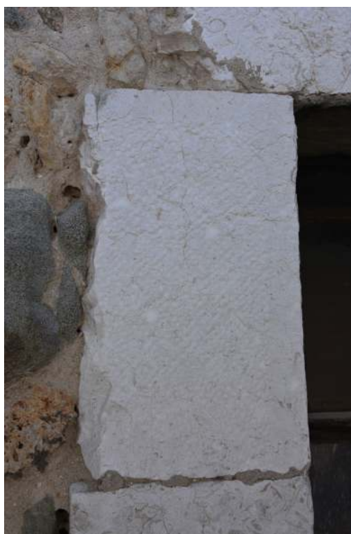
Piédroit en calcaire blanc, traces de taille
