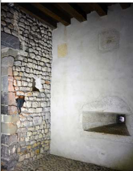
Intérieur de la tour, petit appareil sur le mur sud
