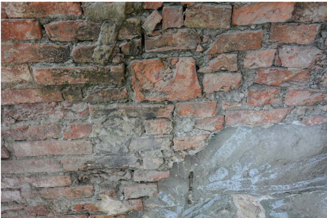
Ragréage (UC 28.11) du parement en molasse
