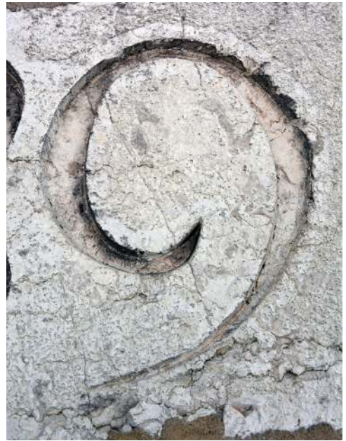
Traces de taille au ciseau, à la gradine (peut-être boucharde?) et badigeon rouge dans les chiffres
