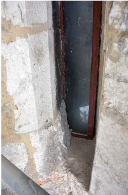
Jour d'angle UC 32.02, agrandi en porte (UC 32.04) et rebouchage en restauration (UC 32.05) : seuls le piédroit oriental et le linteau du jour d'origine sont conservés.
