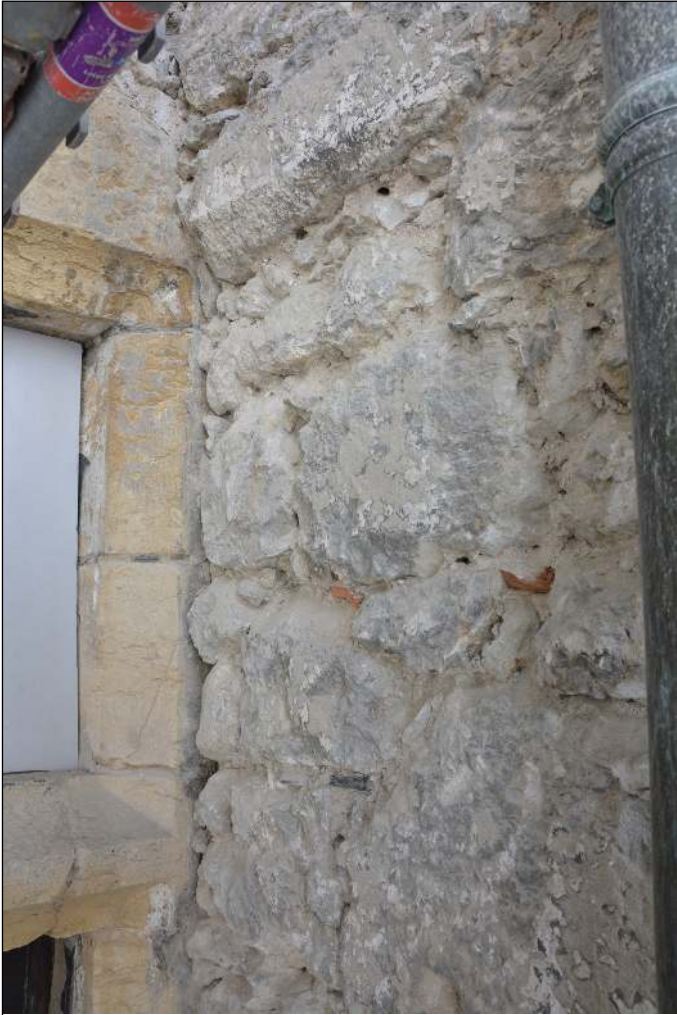
Désaxement du parement UC 29.05 pour dégager le piédroit sud de la fenêtre UC 28.05 du Vieux Logis
