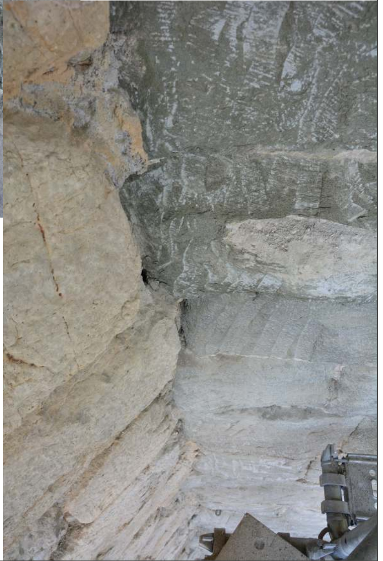
Tour Saint-Pierre. Appui du parement de la tour (en calcaire à gauche) contre le mur des cuisines (M28, en molasse à droite)
