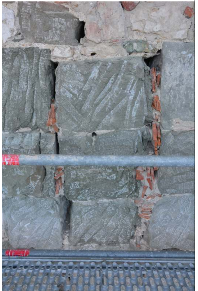
Emplacement bouché d'une console de mâchicoulis
