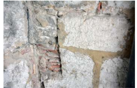
Trou de poutre UC 32.06 sous le seuil de la porte percée dans M 32, fonctionnant avec la poutraison de la galerie du mur M31
