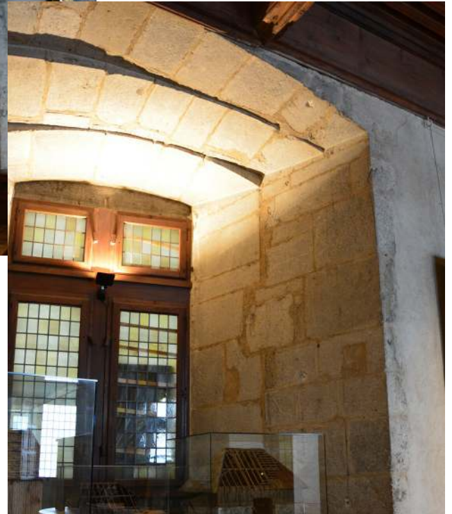
Traces de taille à la boucharde et au ciseau
