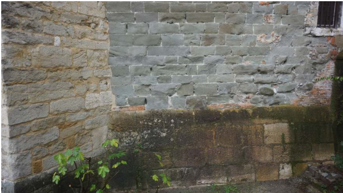
Parement taluté en calcaire (UC 28.12)
