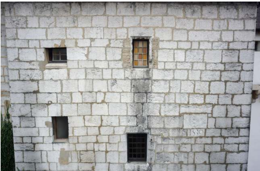
Jour UC 33.08 au deuxième niveau, modifié par l'aménagement des latrines en batterie et de la fenêtre UC 33.03
