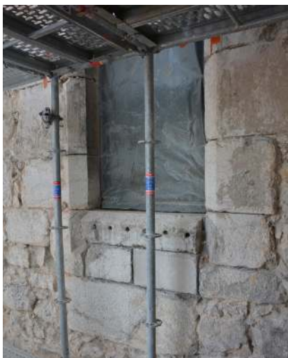
Fenêtre UC 30.03 modifiée en porte, puis niveau d'appui changé
