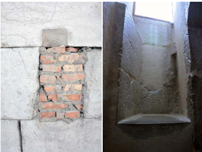
Jour UC 33.08 au deuxième niveau, modifié par l'aménagement des latrines en batterie et de la fenêtre UC 33.03
