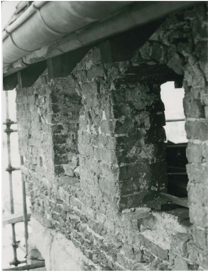
Tour Saint-Pierre. Mâchicoulis et baies-crèneaux aujourd'hui et lors des restaurations de 1972.
