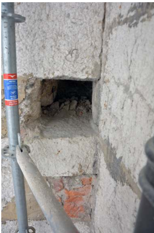
Trou de poutre vidé UC 31.24 et trou de poutre bouché UC 31.32 à l'angle entre M 31 et M32
