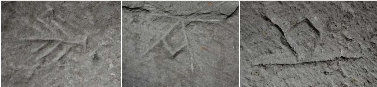
Exemples de signes lapidaires conservés sur le parement en molasse
