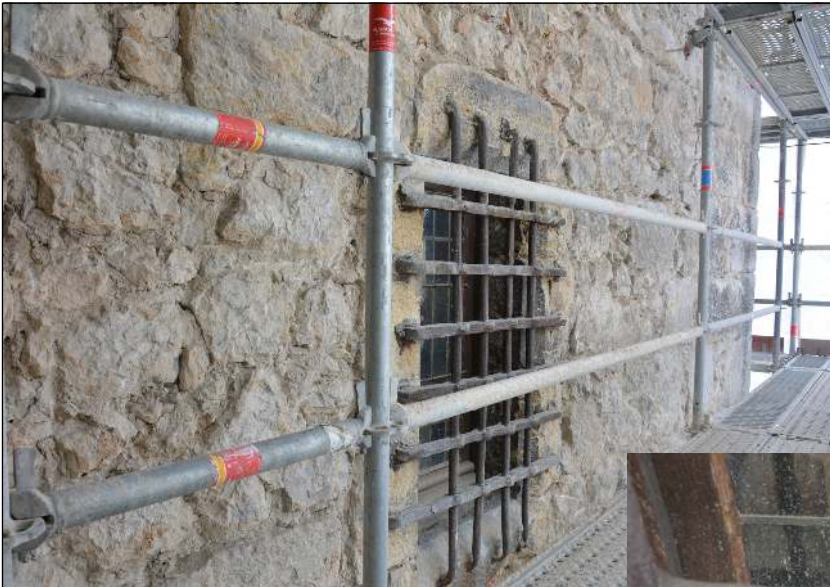
Fenêtre UC 29.03 en calcaire jaune, trous d'ancrage de grille dans l'appui
