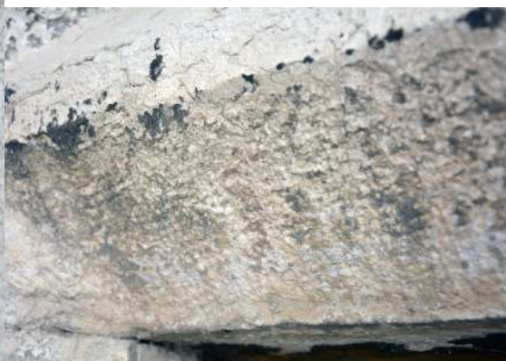
Traces de taille à la boucharde et au ciseau
