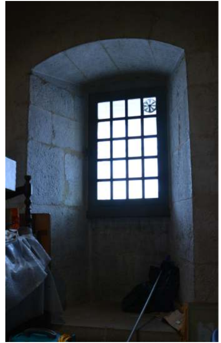
Fenêtre UC 34.04 au deuxième niveau
