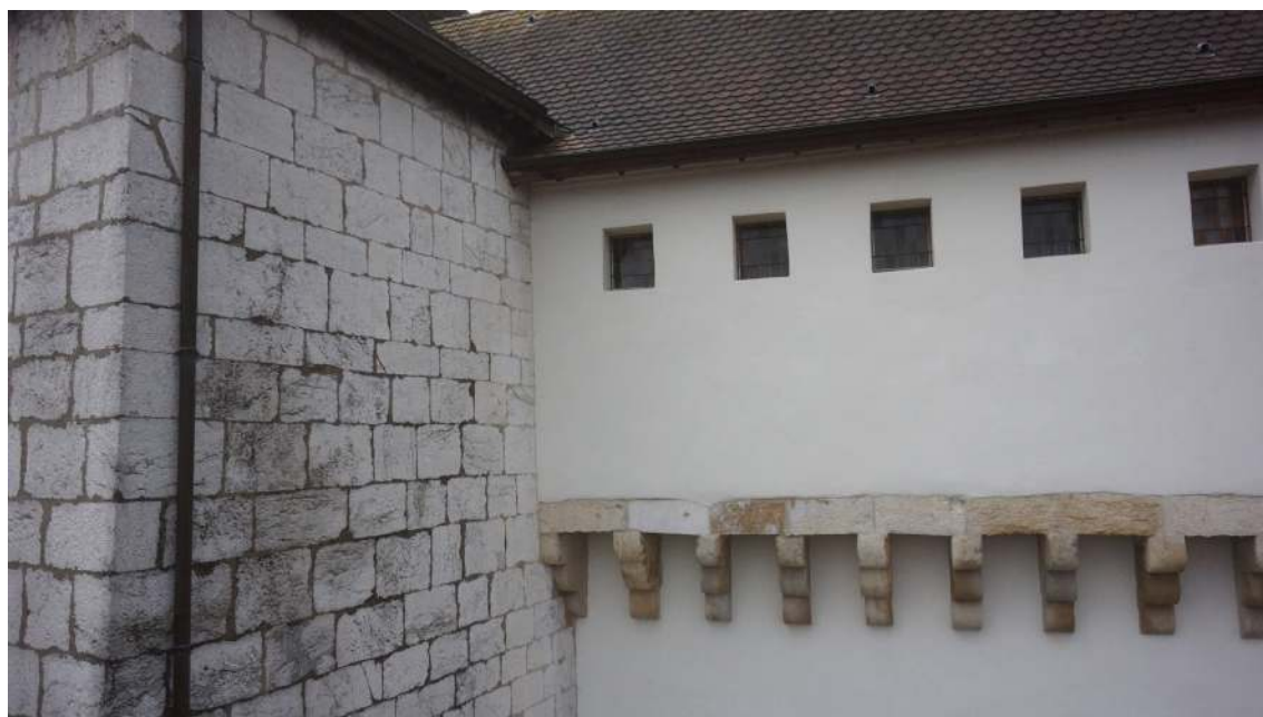
Les matériaux et les mâchicoulis du pan de courtine nord.
