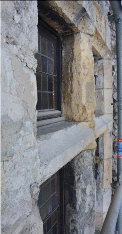
Décor de gorge et dégradation du calcaire Dégradation du congé du piédroit nord
