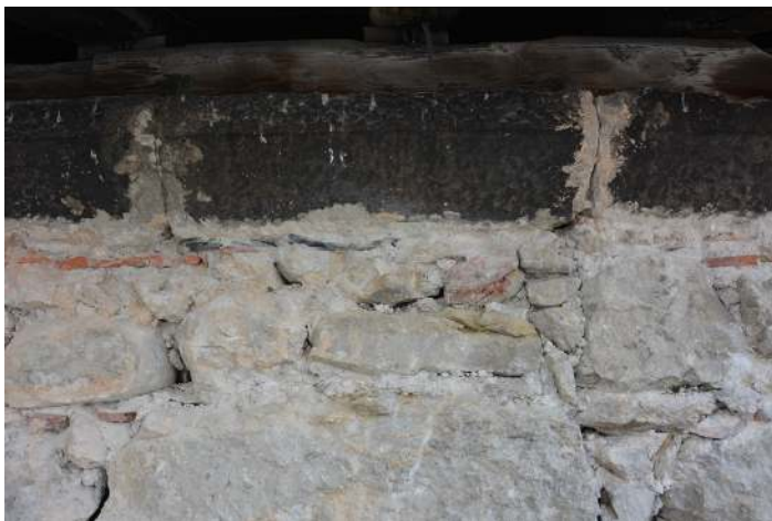
Détails du mode de construction du parement UC 30.06, chânage entre les murs nord et ouest
