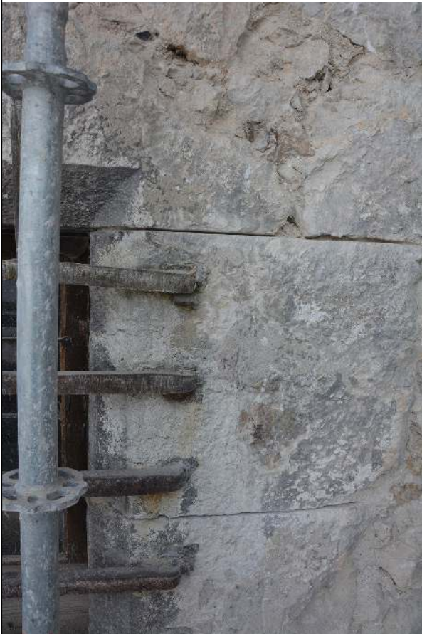
Fenêtre UC 30.04 en calcaire blanc, trous d'ancrage avec métal en périphérie
