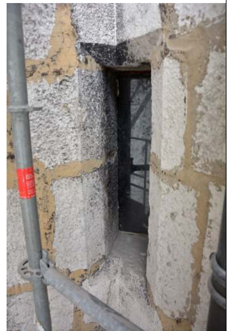
Jour d'angle 32.01 entre le Logis Nemours et la tour du Trésor au troisième niveau
