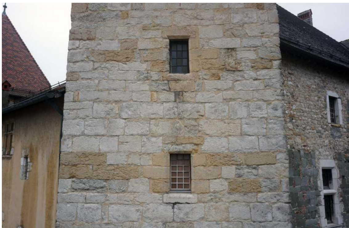
Tour Saint-Pierre. Changement d'appareil entre le niveau 2 et le niveau 3 (en haut) et fenêtres UC 26.01 et UC 26.02 (en bas).
