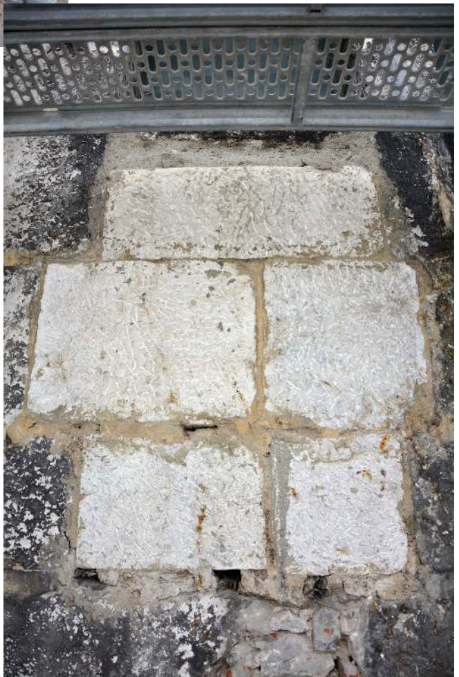
UC 31.04, reprise sous la baie orientale et bouchage au ciment
