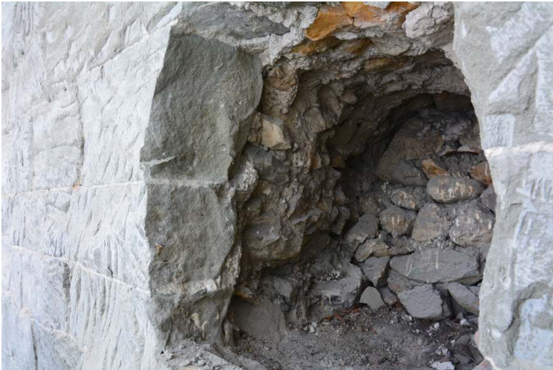
Cavité dans le parement en molasse (UC 28.09)
