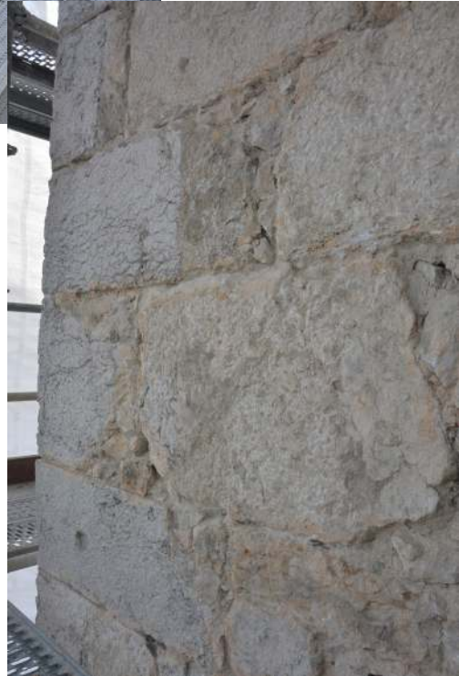
Détails du mode de construction du parement UC 30.06, chânage entre les murs nord et ouest
