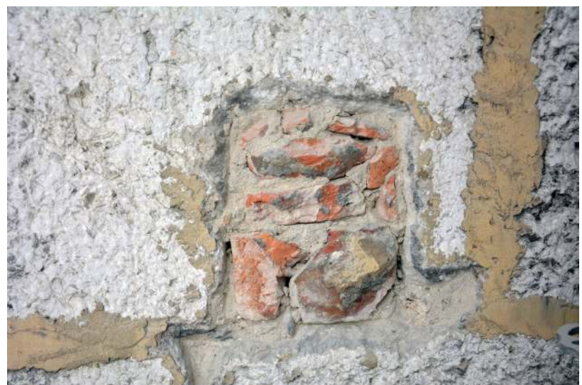
Trou de poutre bouché de briques UC 31.31
