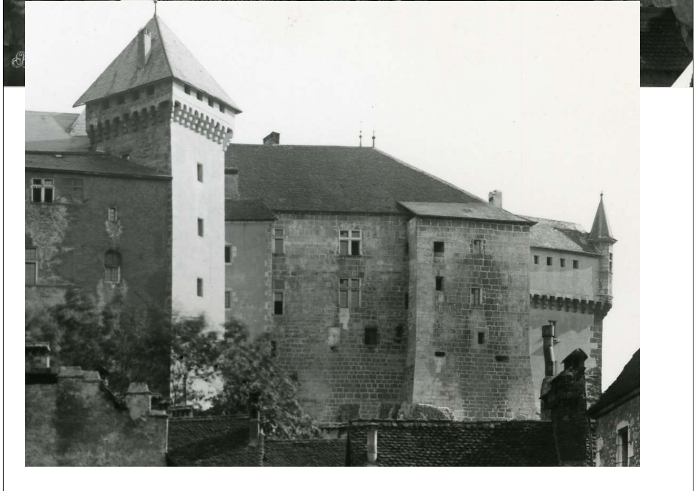
Logis Nemours et tour du Trésor. Façades nord en 1882.
