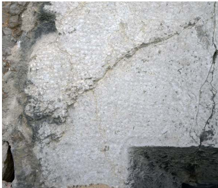
Traces de boucharde sur le linteau de la fenêtre UC 31.06.
