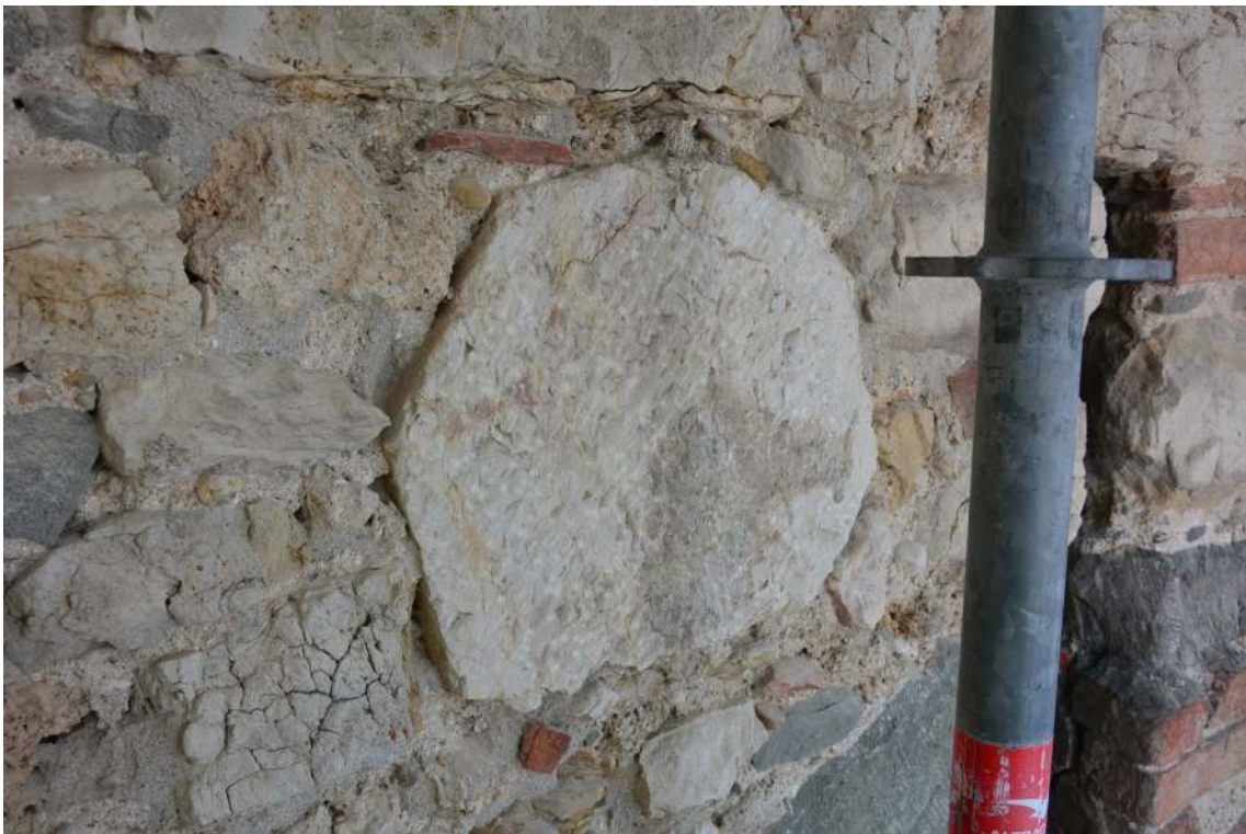
Fût remployé dans le parement (UC 28.08)
