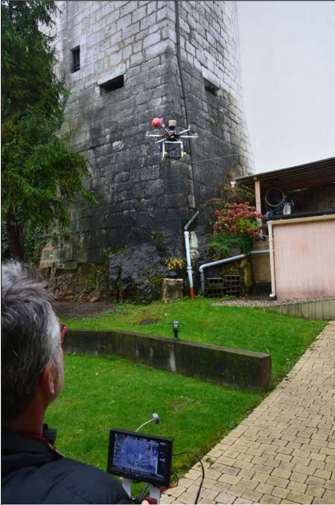
Couverture photographique réalisée au drone
