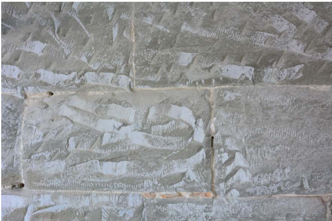
Parement en molasse (UC 28.09). Détail des joints après dressage mécanique du parement.
