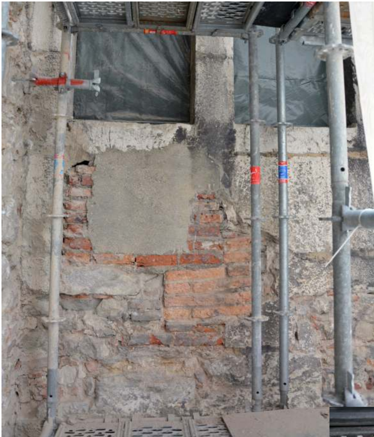
UC 31.03, agrandissement de la fenêtre et transformation en porte, puis bouchage.
