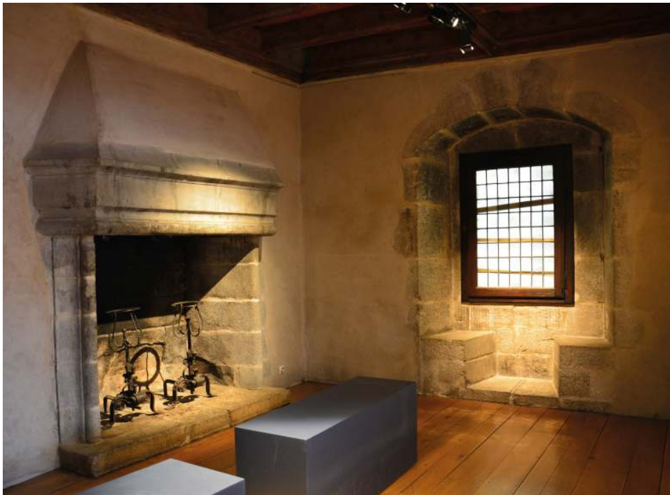
Cheminée du mur sud et fenêtre à coussièges du mur ouest
