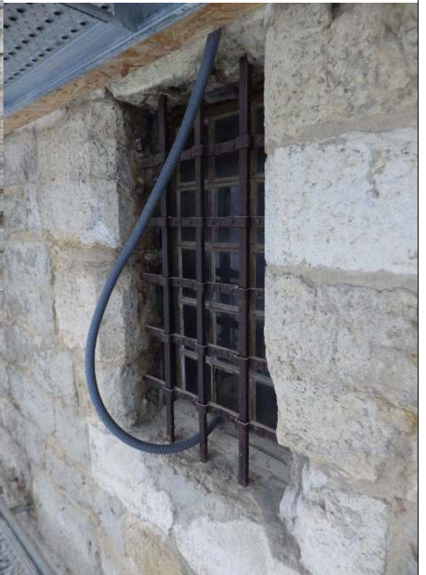
Tour Saint-Pierre. Fenêtres UC 26.03 du premier niveau (en bas) et UC 26.04 du deuxième niveau (en haut).
