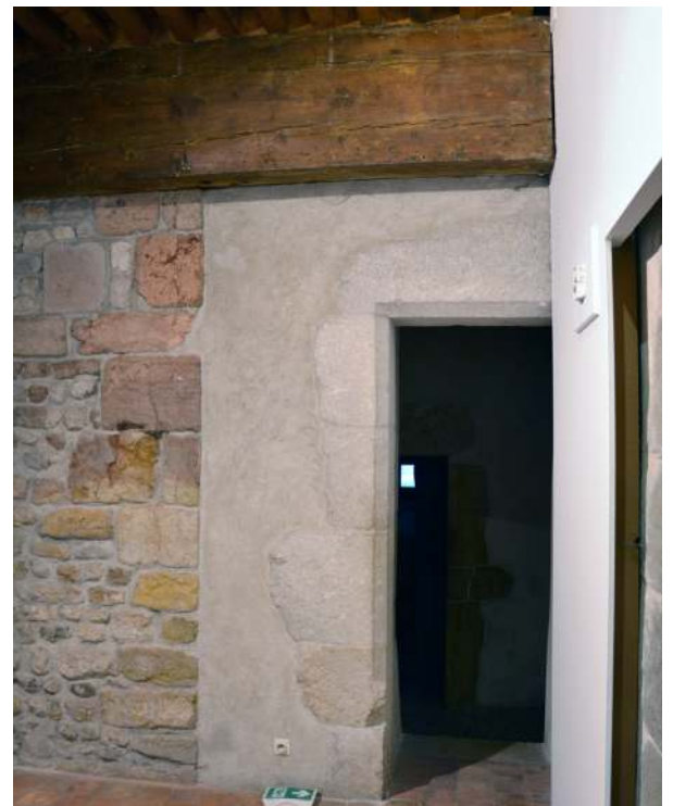
Chainage d'angle oriental de la tour primitive et extension vers l'est au niveau des latrines
