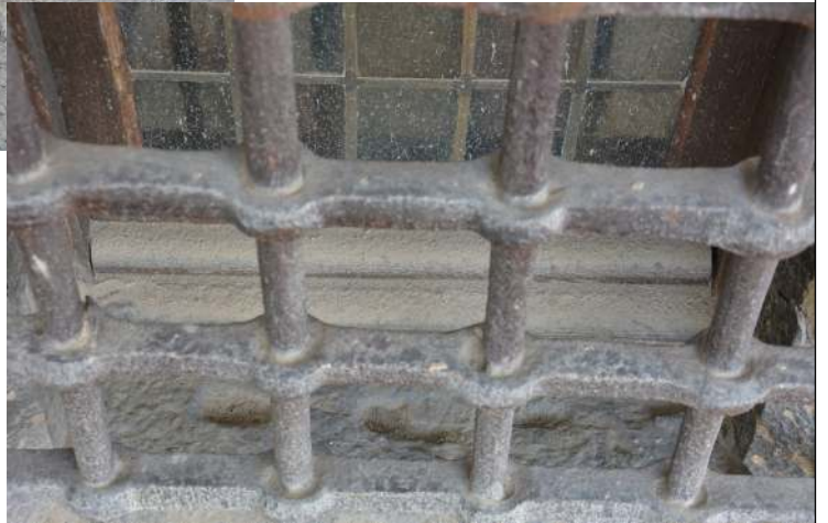
Fenêtre UC 29.03 en calcaire jaune, trous d'ancrage de grille dans l'appui
