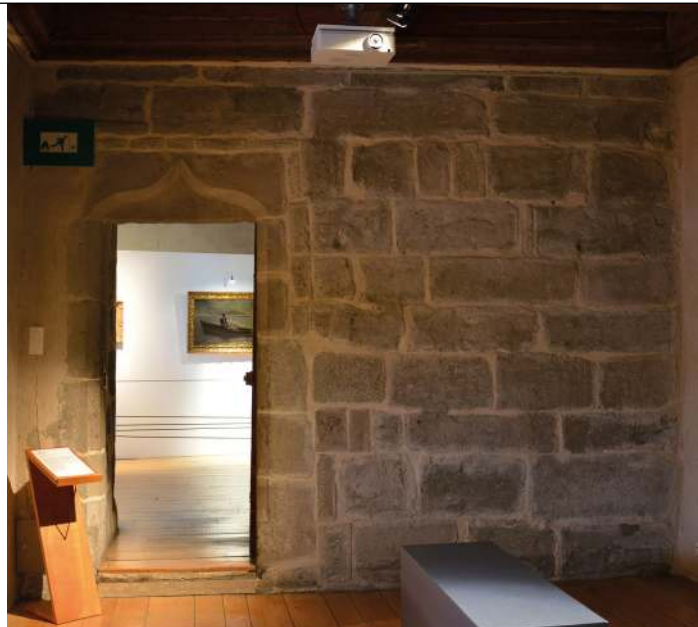
Exemples de signes lapidaires conservés sur le parement en molasse
