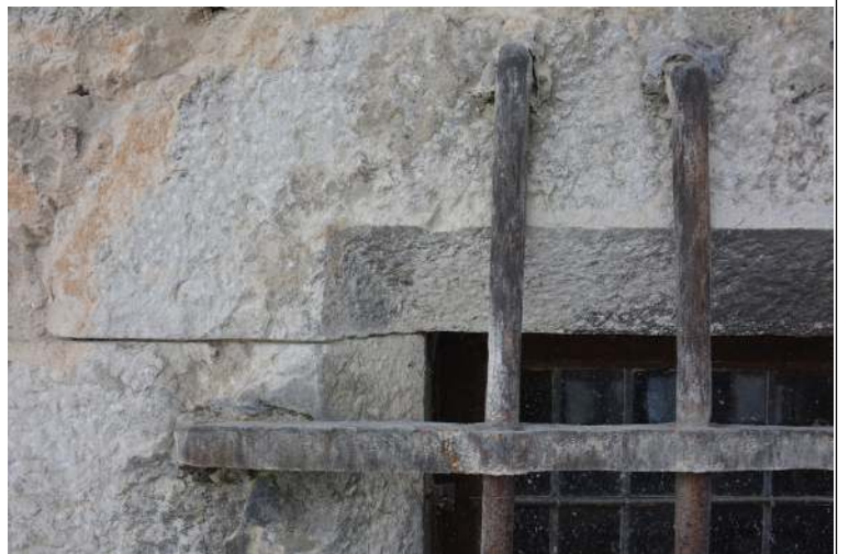
Fenêtre UC 30.04 en calcaire blanc, trous d'ancrage avec métal en périphérie
