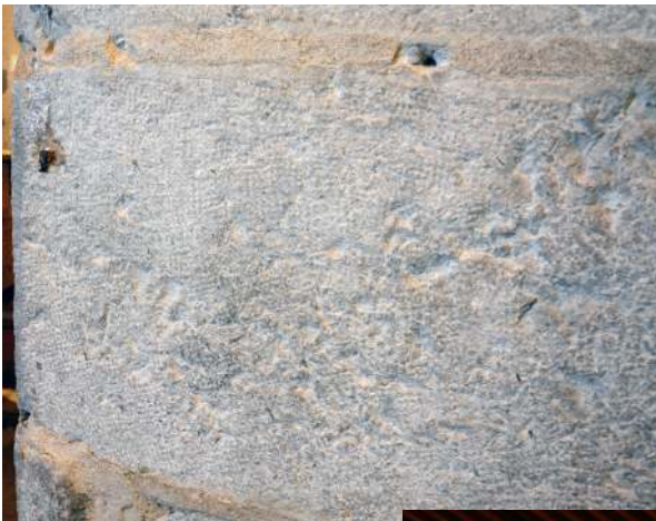
Traces de taille à la boucharde et au ciseau
