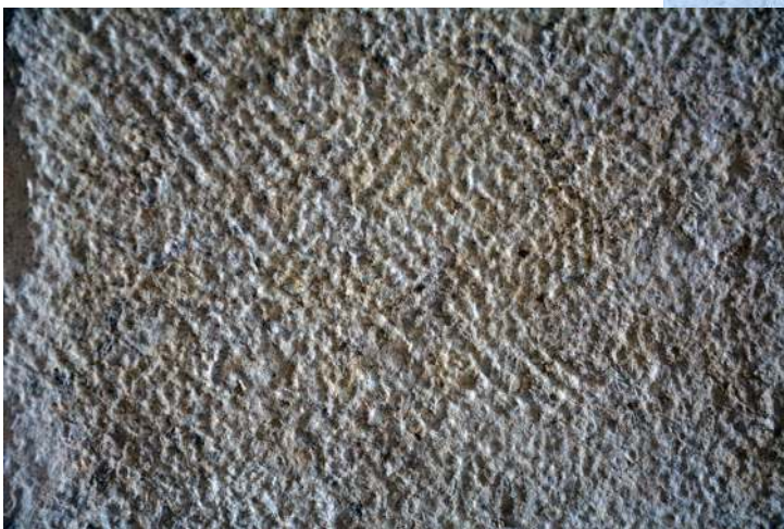
Traces de boucharde. Ici les traces sont plus fraîches et sont dues à la restauration des années 1958-1960 : elles recouvrent toute la surface des moellons, y compris les arêtes, qui sont ciselées sur les moellons taillés au XVI e siècle.
