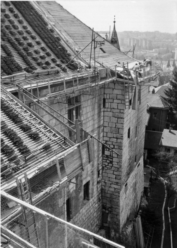
Porte bouchée visible sur un cliché des travaux de restauration de la couverture en 1988.
