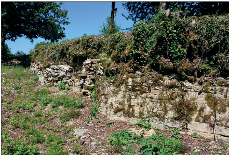
1. Contrescarpe du fossé oriental.
