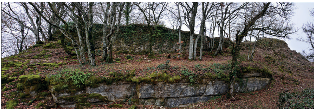
1. Fossé et courtine est en avril 2016, avant déboisement, vus de l'est.
