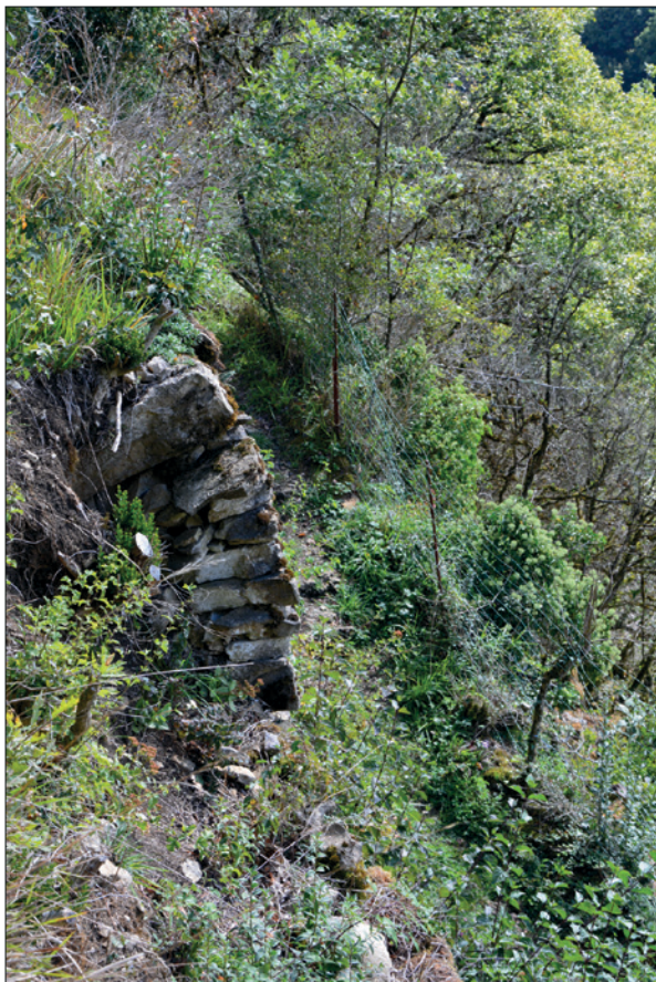
1. Moellons en équilibre, sans liant, au-dessus du chemin sud.
