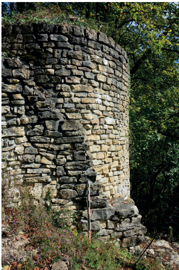
2. Détail de la partie restaurée.
