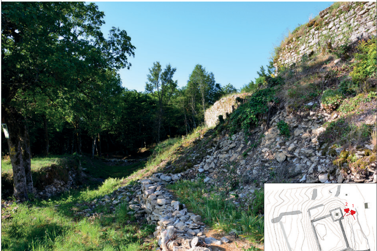
2. Emprise du fossé oriental.
