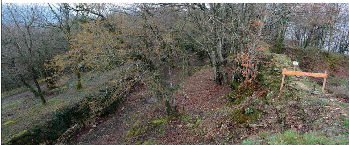
2. Fossé et courtine est en avril 2016, avant déboisement, vus de la tour carrée.
