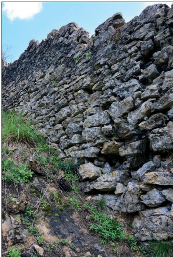
1. Base du parement sapée par l'érosion et des chutes de blocs.
