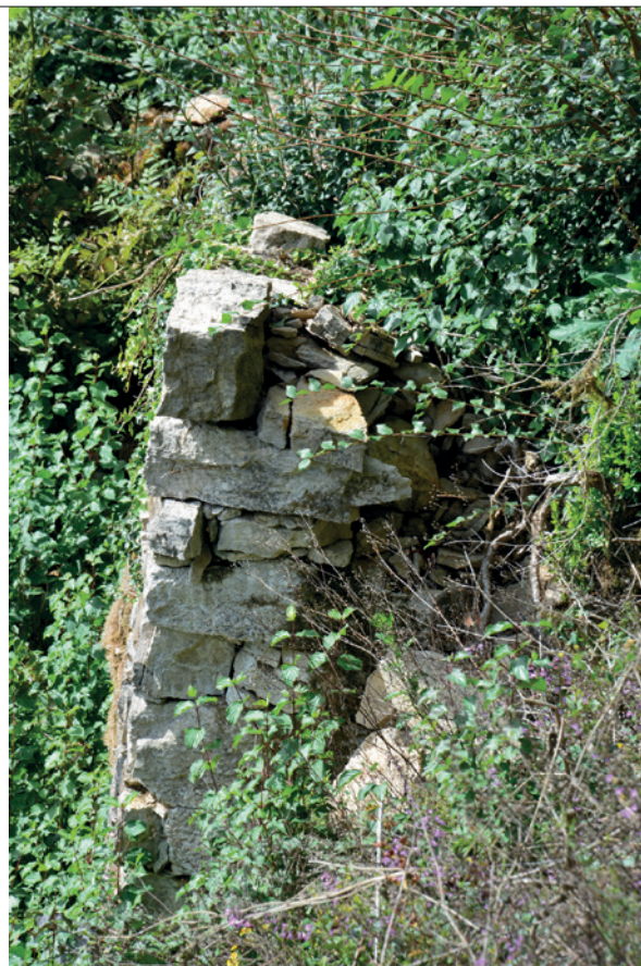
2. Moellons en équilibre, sans liant, sous le chemin sud.
