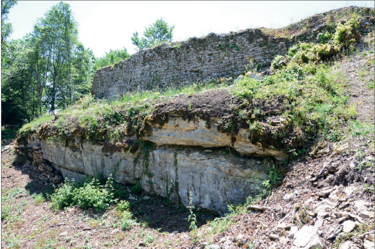
1. Courtine orientale de la cour haute et escarpe du fossé.
