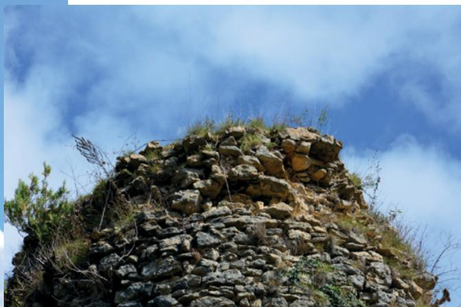
4. Mortier lessivé et blocs en équilibre.
