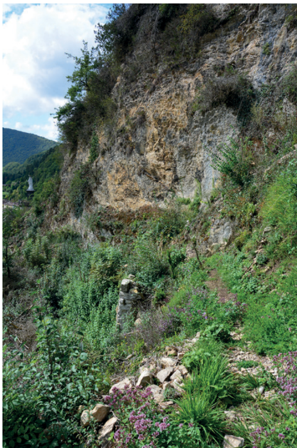
2. Chemin sud passant sous la falaise et la courtine sud-ouest.
