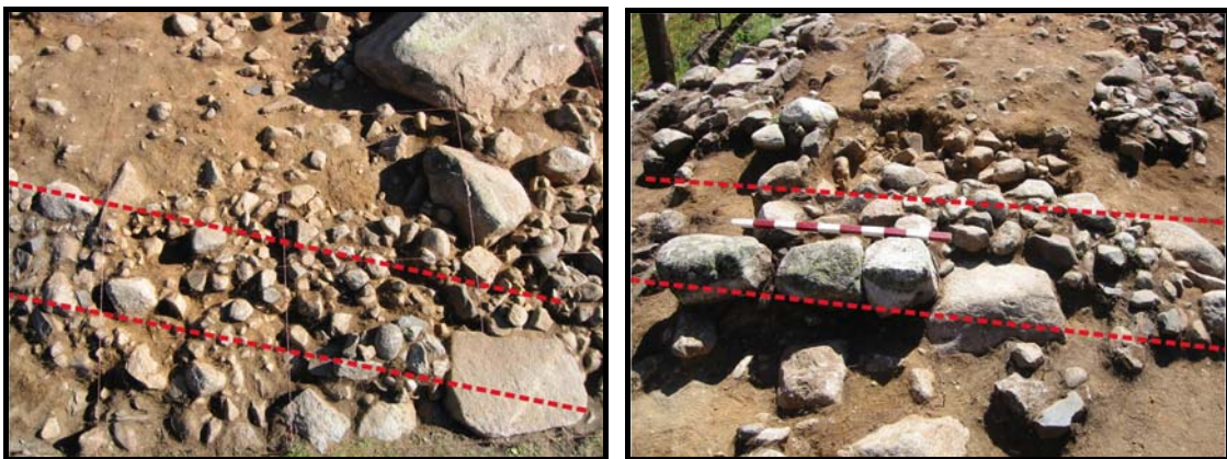
Localización de los muros sur (a la derecha) y oeste (a la izquierda) qui montrent de architectures différentes
