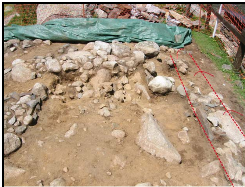
Procédé de destruction de la partie est du mur nord
