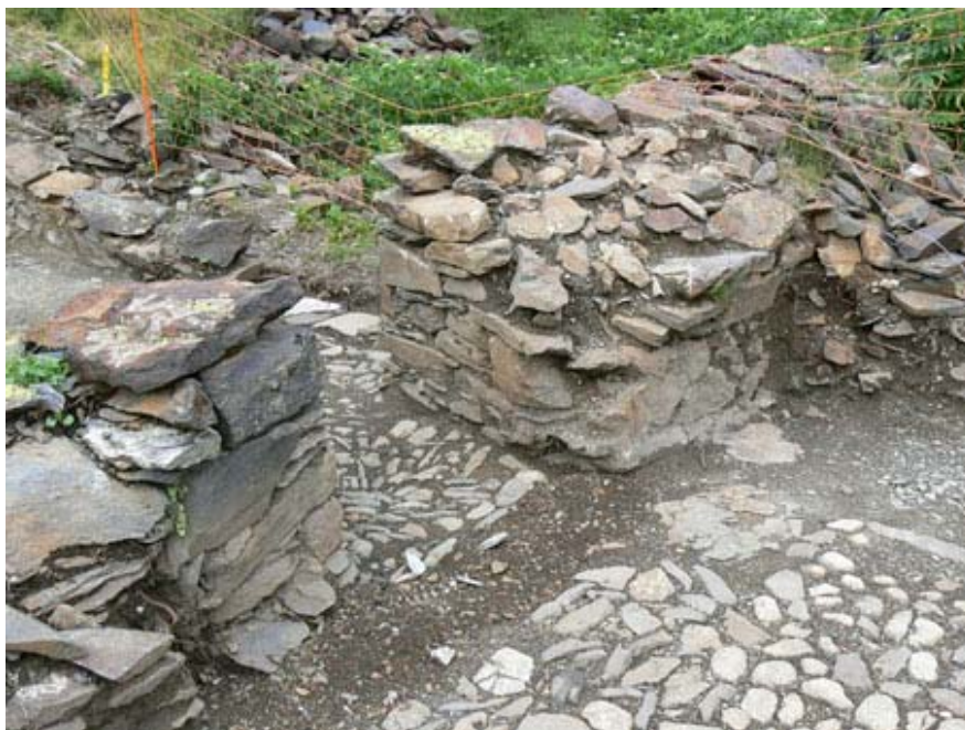
Vista desde el suroeste del muro UE 10 en relación con los suelos UE 30 y 46, y el umbral 47 de la primera fase muraria del Hospital.
