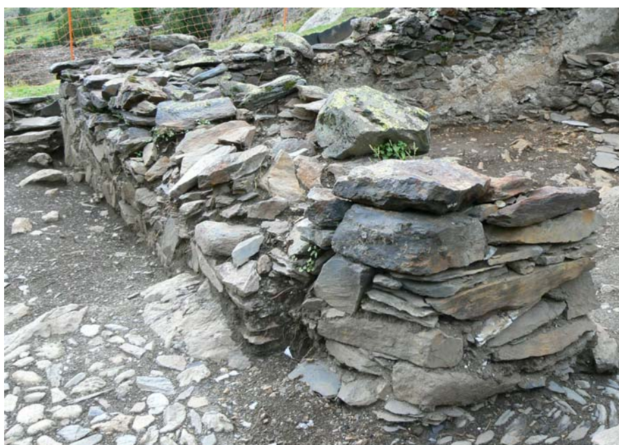
Vista desde el sureste de las UEs 38 y 46, en el exterior del Cuarto Hospital. Se observa cómo el muro UE 39 apoya sobre el geológico UE 38 que aflora enmarcando el suelo UE 46.
