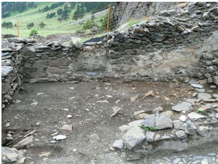
Vista Frontal de UE 16 desde el este. Se aprecia la Alacena abierta en su paramento interior.
