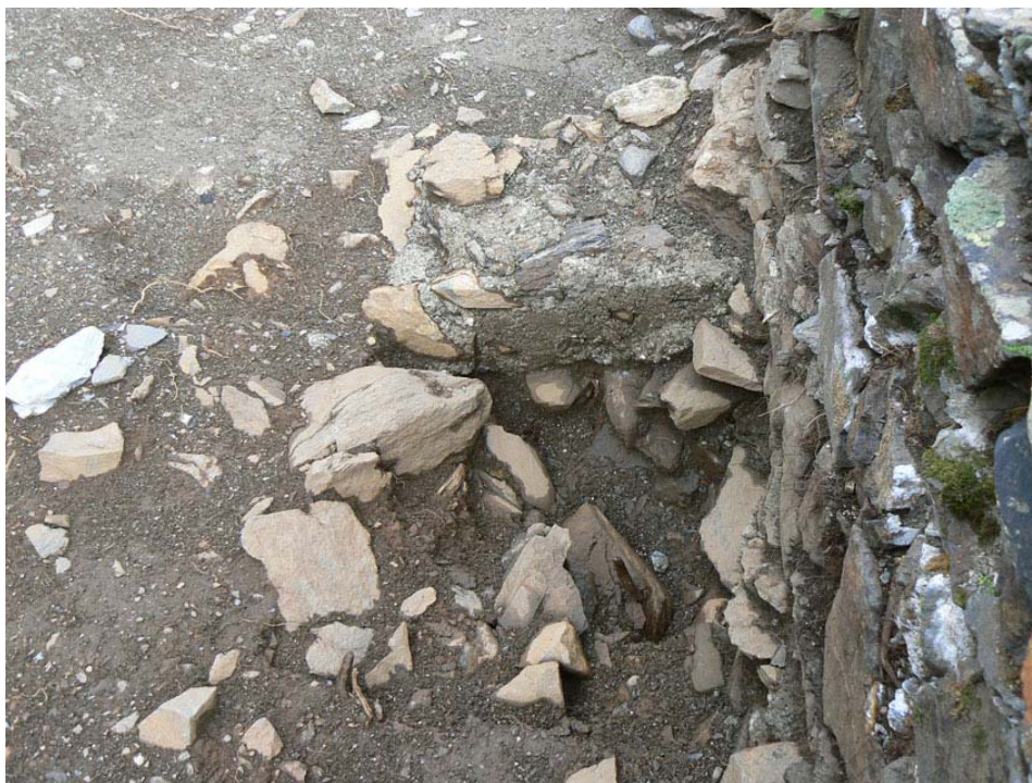
Vista desde el oeste del muro UE 60, y de su cimentación UE 62.
