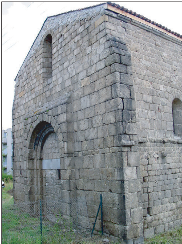
Façade occidentale de la chapelle. Le portail est aménagé dans un massif rectangulaire en saillie sur la façade. Le clocher-mur qui couronnait la façade a disparu.
