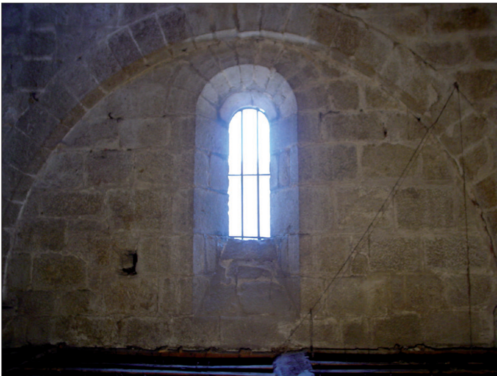
Détail de la baie sud de la travée occidentale (BAI 1018) et de la grande arcade.
