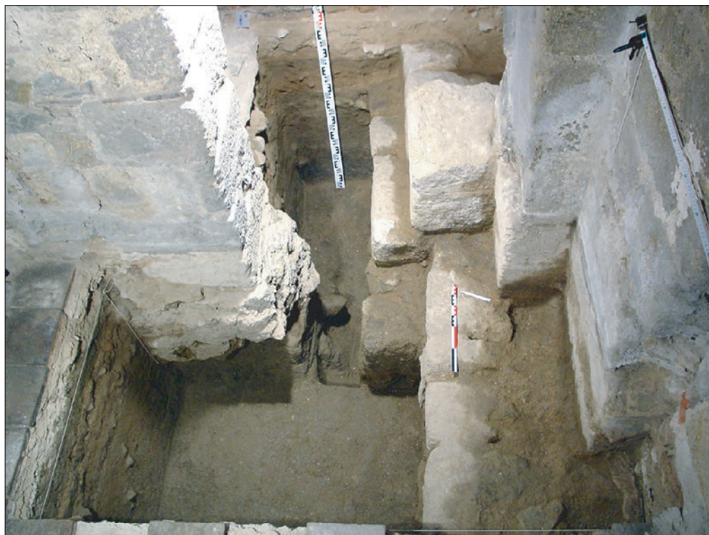
Sondage 2. Fondations de la nef et du choeur roman.
