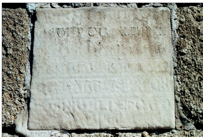
Etat actuel de la plaque épitaphe de Bertrand de Barres, scellée en façade sud de la chapelle.
