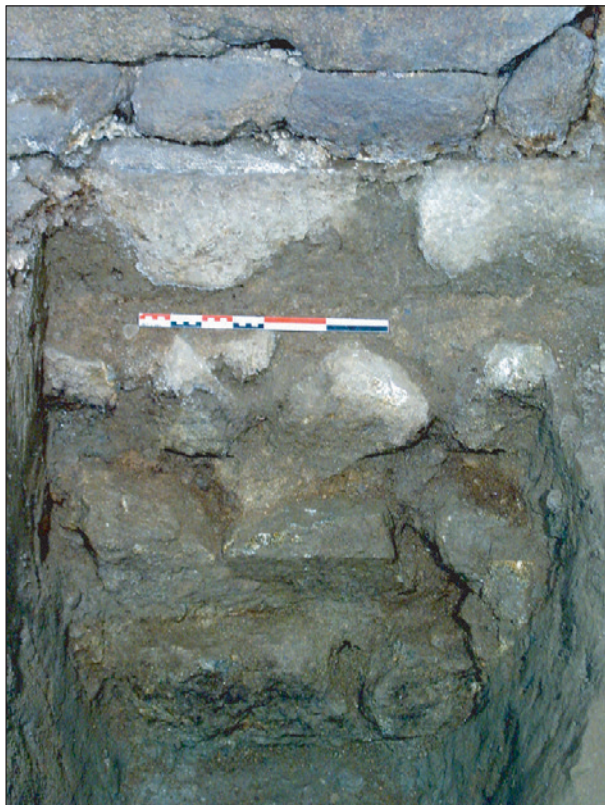
Sondage 3. Fondation de la façade occidentale, côté est. La fondation du mur est constituée de blocs bruts assisés et présente trois ressauts successifs.
