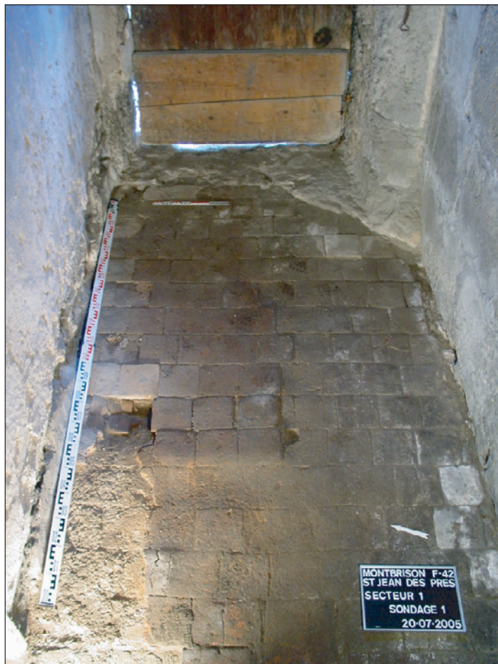
Sondage 1. Etat du sol de tomettes avant intervention, après nettoyage.
