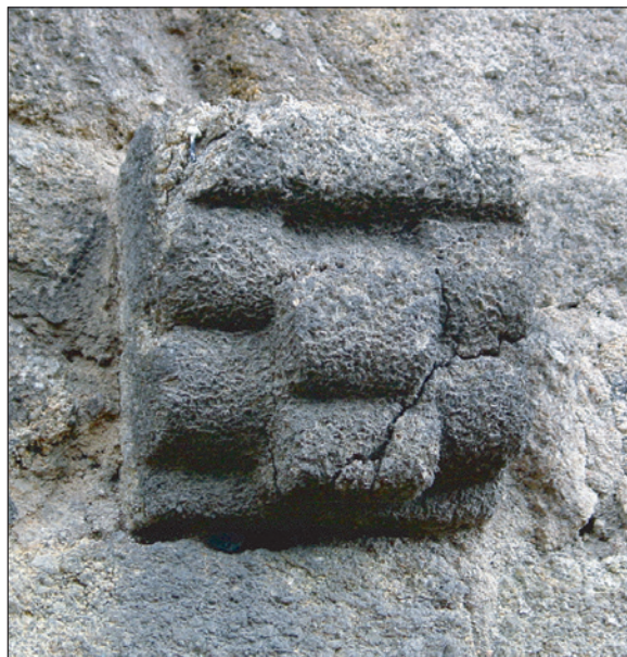
Corbeau de la galerie du gouttereau sud de la chapelle.
