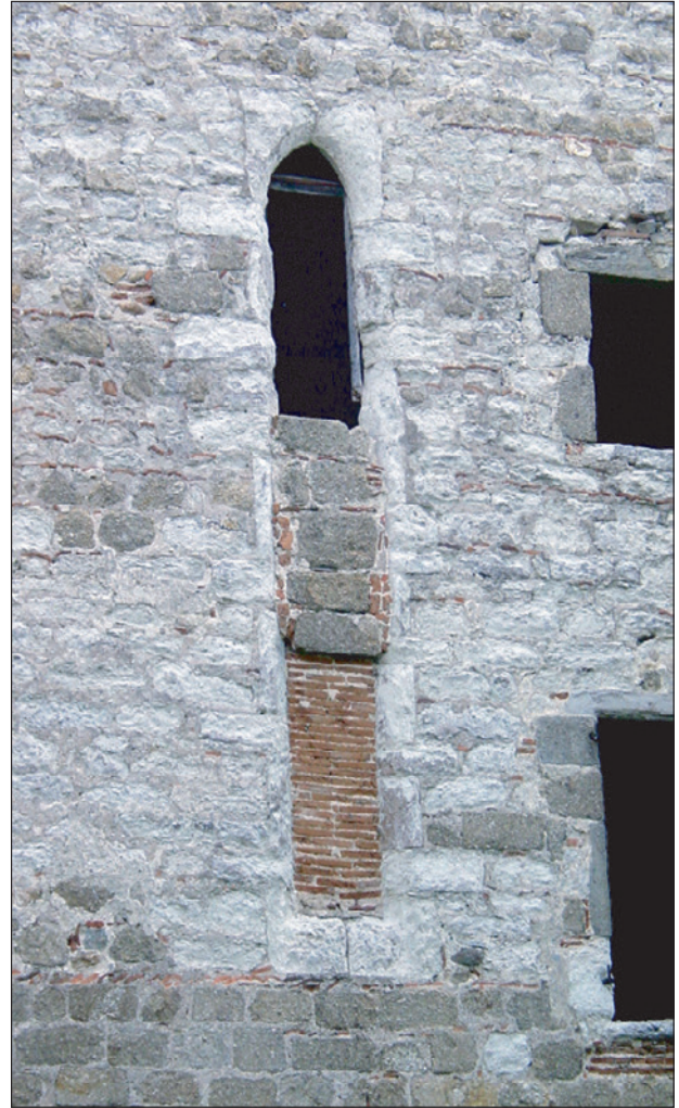
Lancette du mur nord du choeur.
