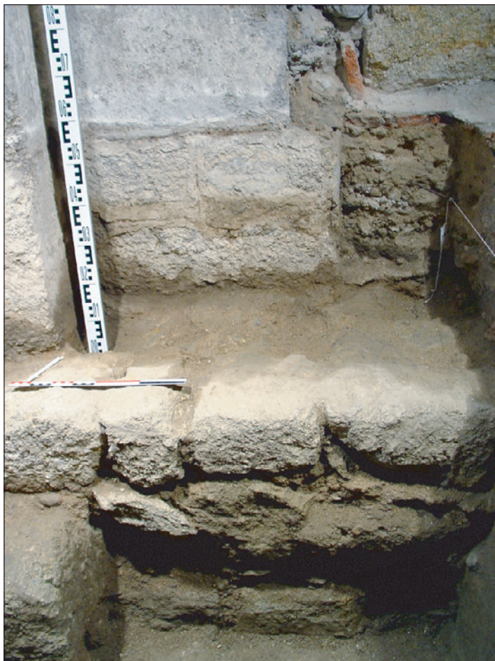
Sondage 2. Joints lissés soulignés au fer de l'élévation romane.
