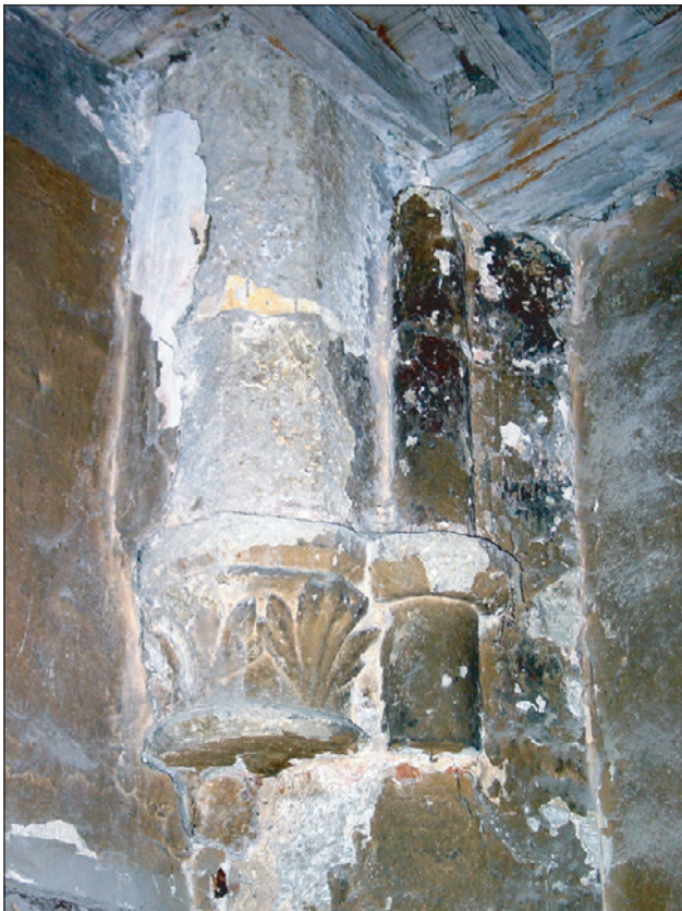
Chapiteau et colonnette de l'arc triomphal gothique, côté nord. Les retombées verticales des colonnettes ont été bûchées lors de la construction des cloisons du XIXème siècle.
