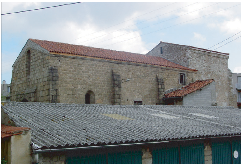
Vue du mur sud de la chapelle. Une série de garages des années 1970 occupe l'emplacement des bâtiments conventuels.
