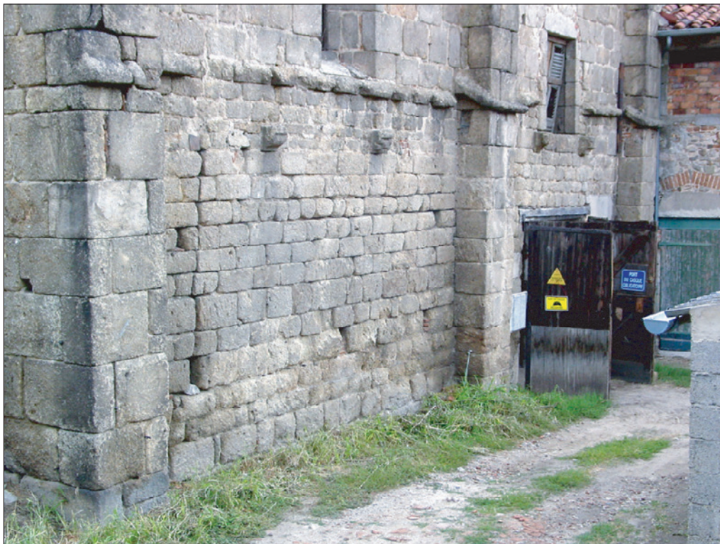
Aménagements liés à la toiture d'une galerie le long du mur gouttereau sud de la chapelle.
