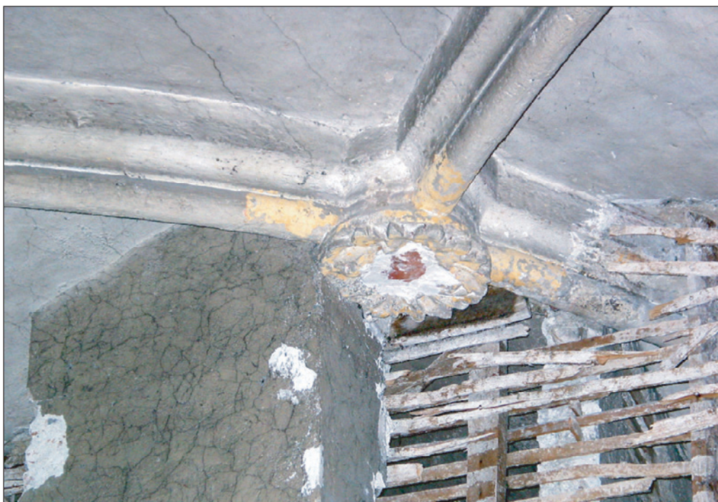
Fig. 25 : nervures et clé de voûte du choeur gothique. Clichés : L. D'Agostino.
