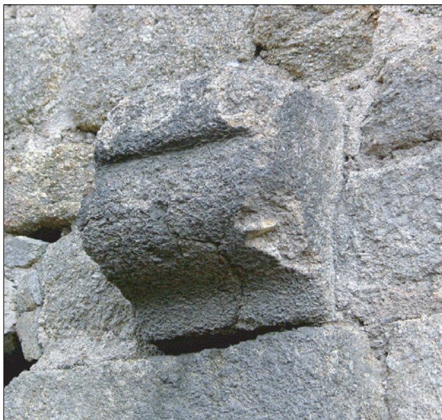
Corbeau de la galerie du gouttereau sud de la chapelle.
