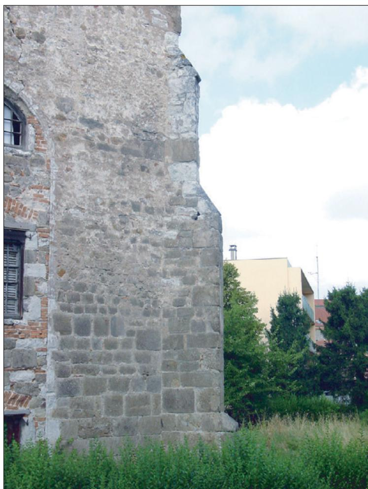
Contrefort biais à ressauts de l'angle nord-est du chevet. Comme le chevet en lui-même, les contreforts sont constitués de matériaux hétérogènes : granit en remploi provenant probablement du chevet primitif pour la partie basse et calcaire plus tendre pour la partie haute.
