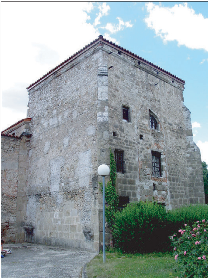
Vue du chevet de la chapelle. Le mur sud du chœur montre les traces d'un bâtiment résidentiel de la commanderie.
