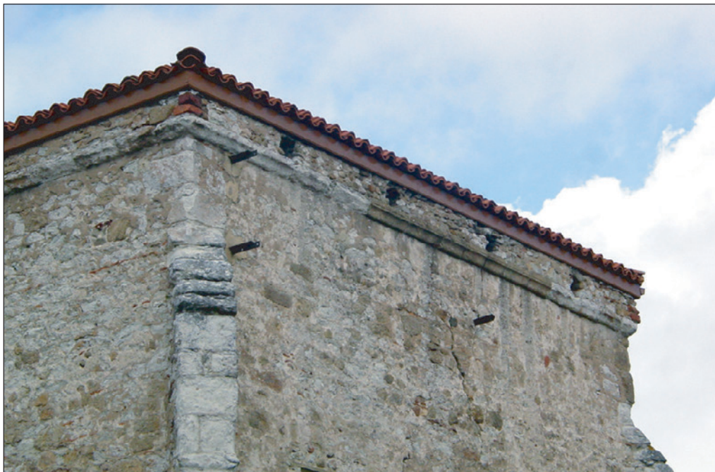
Couronnement du chevet et trous de séchage des reins des voûtes.
