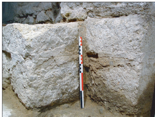
Sondage 2. Joints lissés soulignés au fer de l'élévation romane.
