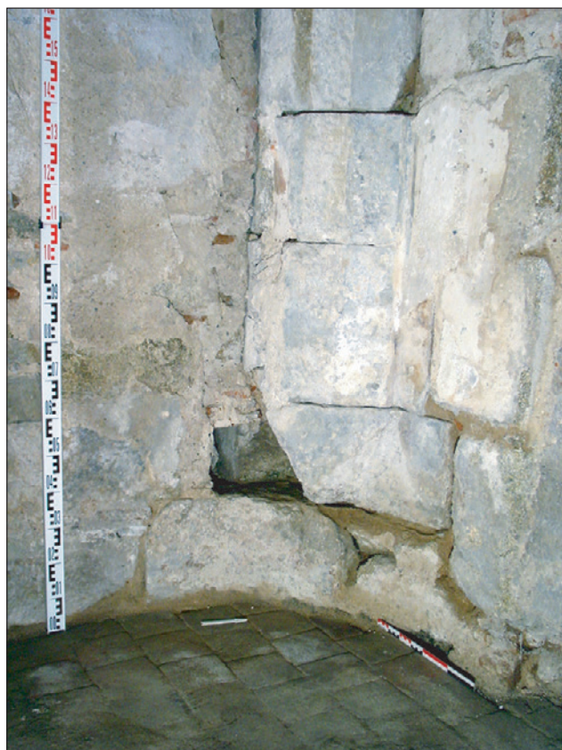
Fig. 16 : pilastre nord à l'articulation entre la nef romane et le choeur gothique. Clichés : L. D'Agostino.
