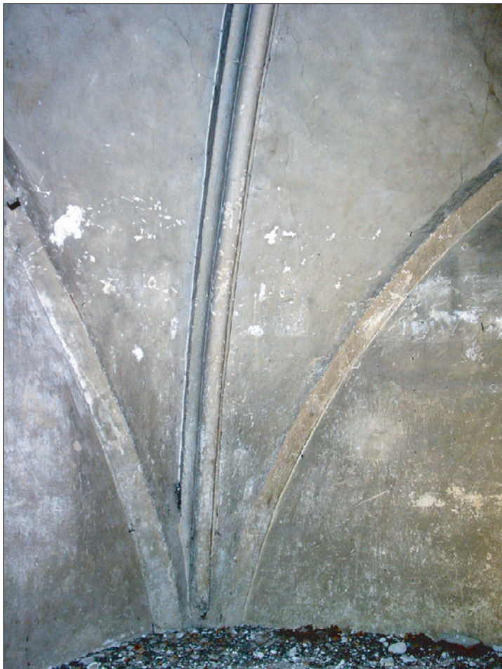
Nervures de la voûte d'ogive du choeur gothique.
