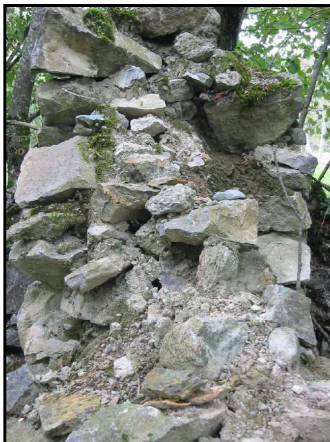
Str. 50 – E23 (détail du mur)
