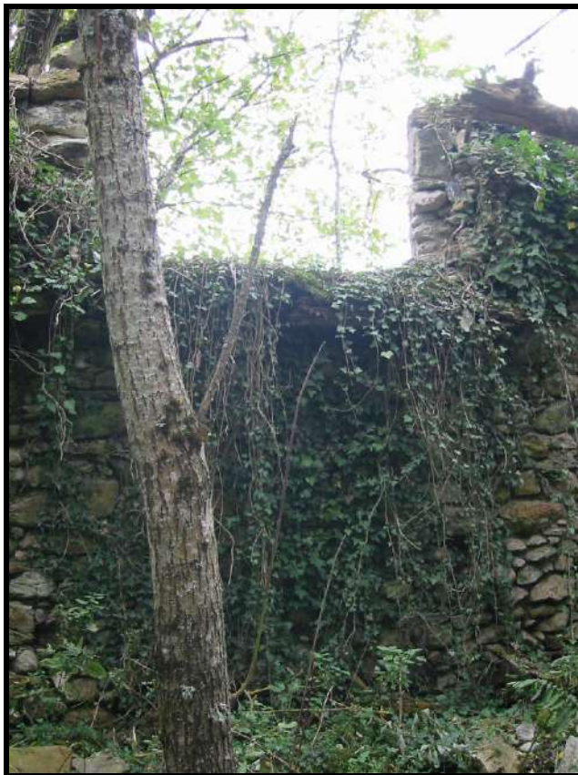
Str. 50 – E23 (détail de la porte du grenier)
