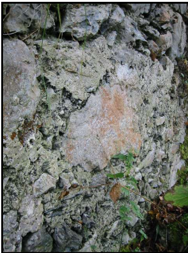
Str. 27 – E10 (détail du mur – face extérieure)
