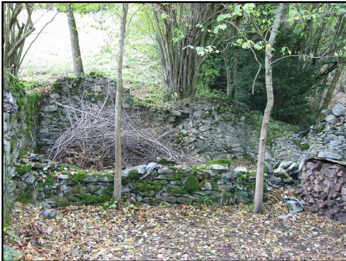
Str. 31 – E13 (détail de la séparation intérieure)
