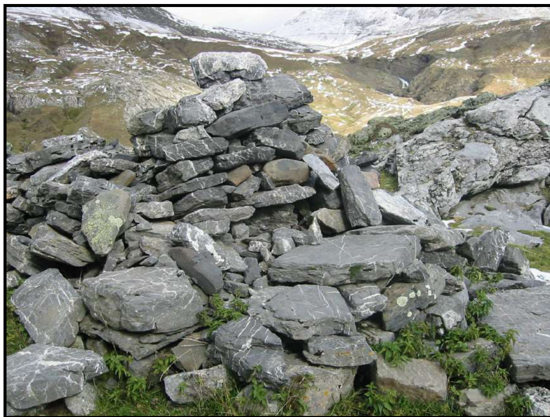
Str. 116 – E39 (détail de la banquette extérieure)
