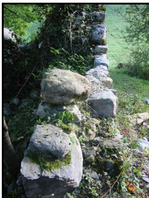
Str. 57 – E26 (détail du mur)
