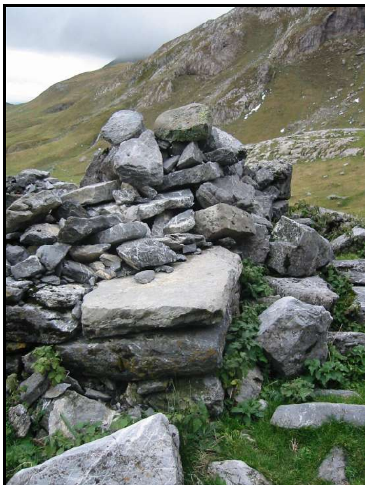
Str. 43 – E21 (détail du chaînon d'angle)
