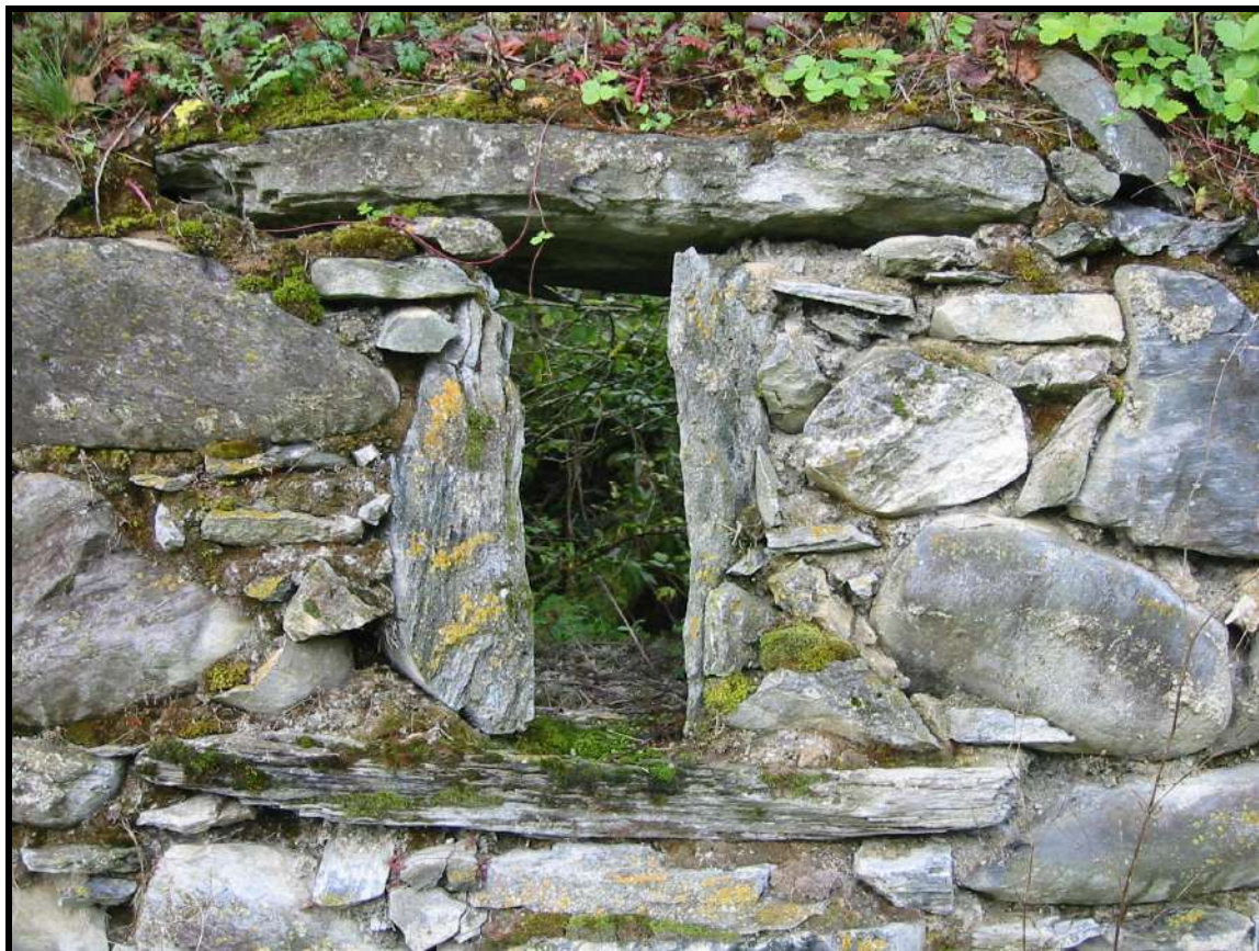
Str. 27 – E10 (détail de la fenêtre – face extérieure)
