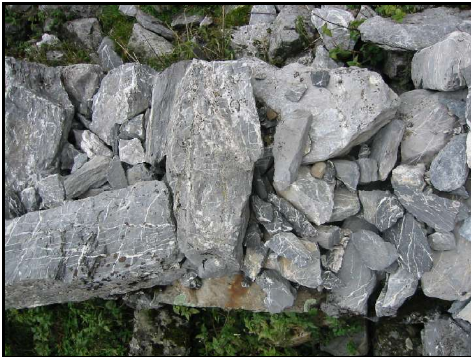
Str. 43 – E21 (détail du mur)
