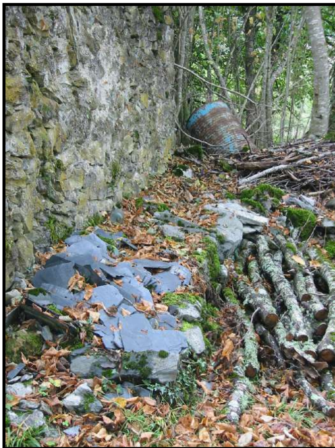
Str. 31 – E13 (détail de la banquette extérieure)
