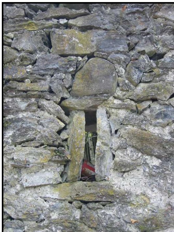
Str. 31 – E13 (détail de la fenêtre – face extérieure)
