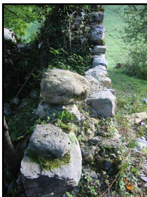
Str. 57 – E26 (détail du mur)
