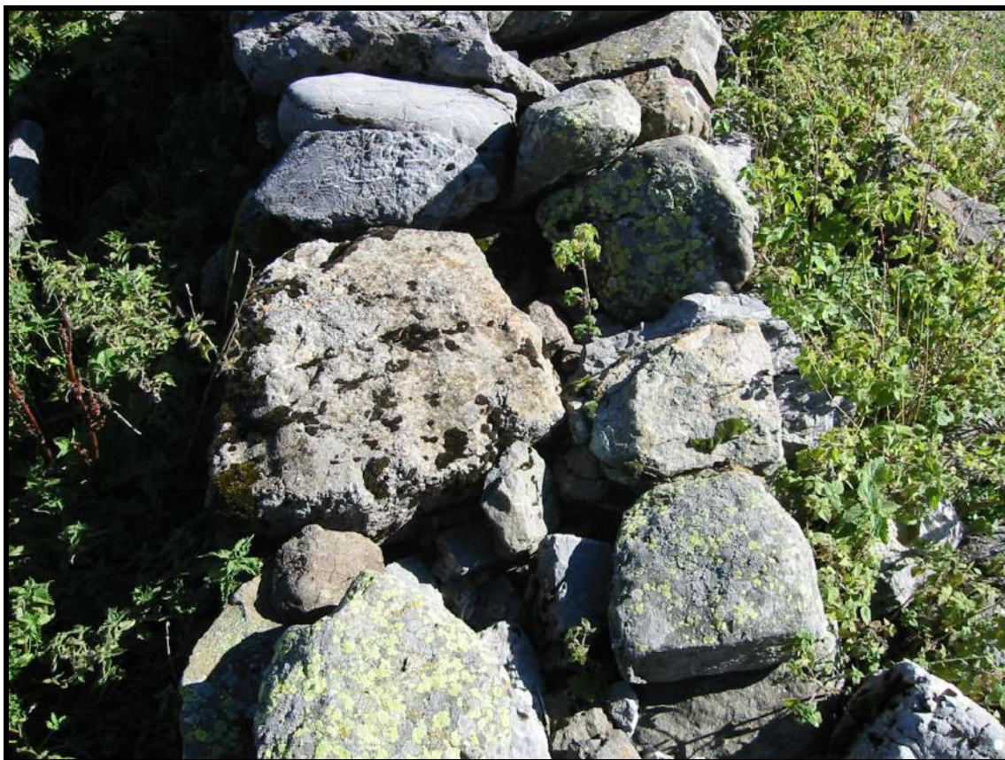
Str. 21 – E7 (détail du mur)
