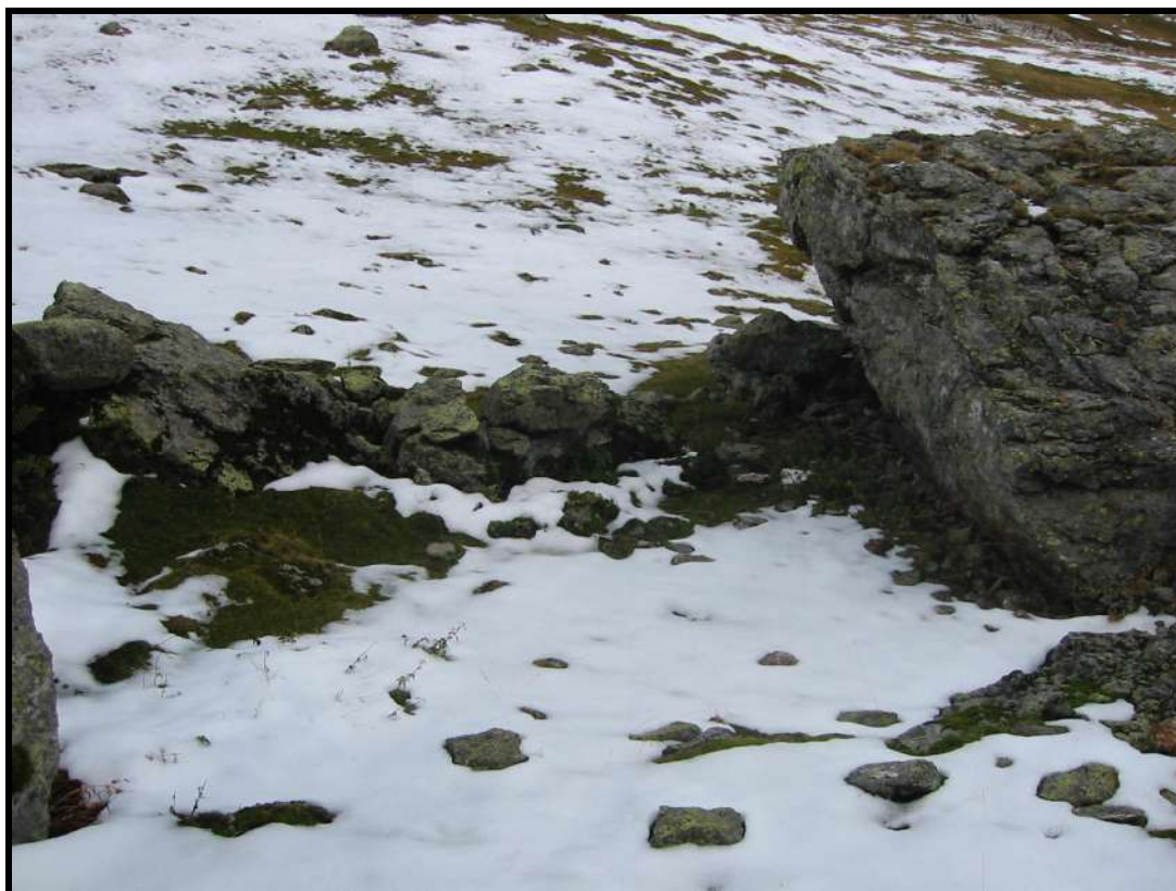
Str. 130 – E42 (détail du mur sud-ouest)
