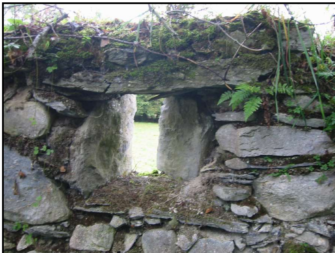
Str. 27 – E10 (détail de la fenêtre – face intérieure)
