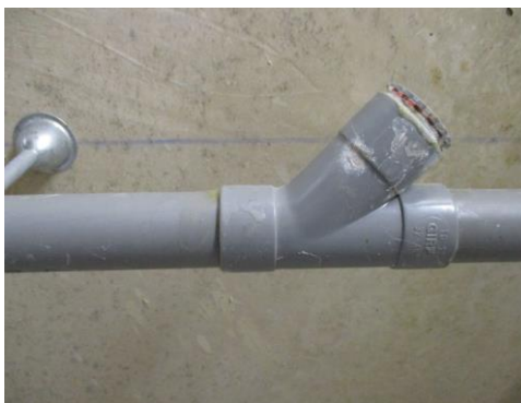
Figure 14 : Té de dégorgeement en Y avec bouchon, Ø 50 mm
