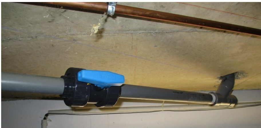
Figure 18 : Vanne à tourner pour la mise en charge d'une portion de réseau (PVC Ø 50 mm) avec du vinaigre blanc
