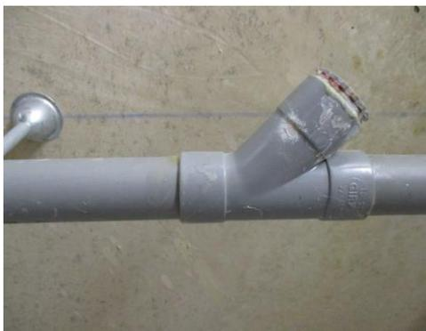
Figure 14 : Té de dégorgement en Y avec bouchon, Ø 40 mm
