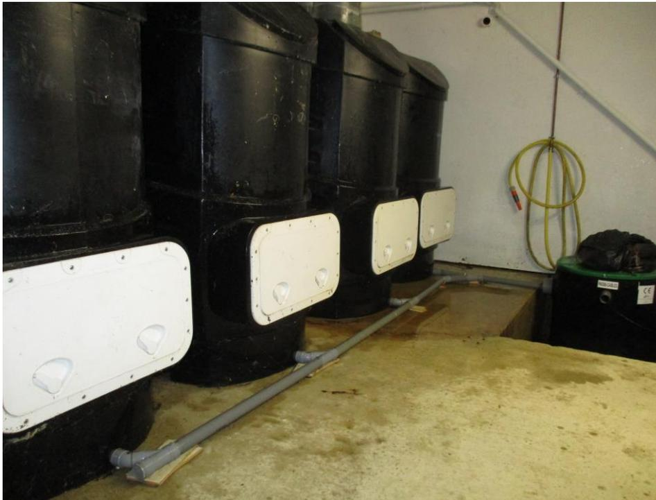
Figure 17 : Réseau de transfert avec des coudes à 22° et 45° Ø 40 mm en apparent puis Ø 75 mm
