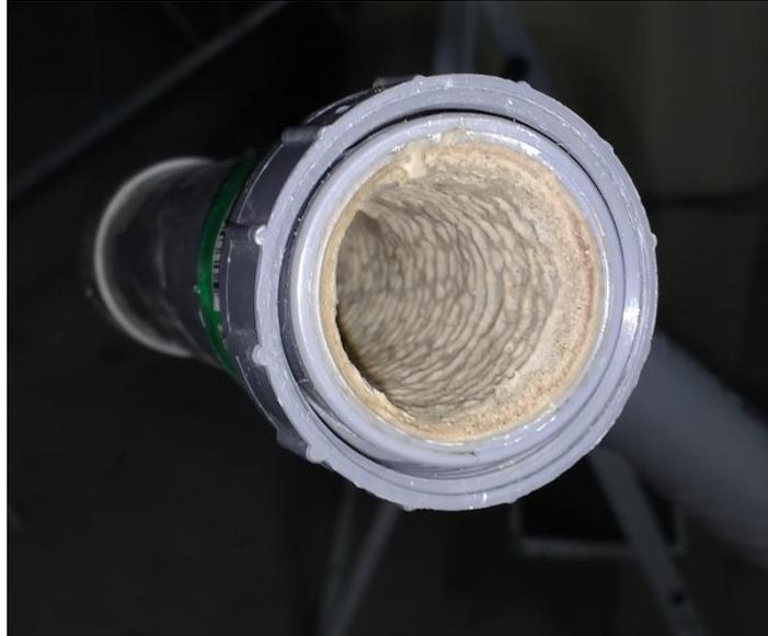
Figure 5 : Incrustation dans un PVC  $\varnothing$  40 mm avec une pente de 4 % en deux ans de fonctionnement. Crédit : Tristan Martin.
