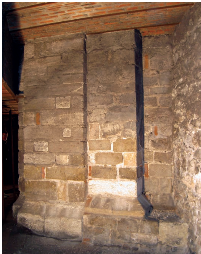
Fig. 6. Orléans (Loiret), Sainte-Croix, calorifère (cl. P. Martin, 2006). À gauche, pile cruciforme de la nef attribuée au chantier ouvert après l'incendie de 989 ; à droite, support accolé du bras nord du transept (les techniques de construction très similaires plaident en faveur d'une datation très rapprochée).
