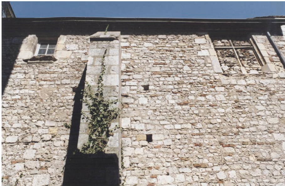
Fig. 9. Orléans (Loiret), Saint-Aignan, sacristie, mur occidental, vue extérieure (cl. P. Martin, 1998). Le petit appareil de moellons avec lignes et insertions de brique pourrait correspondre à une élévation du début du XI e siècle ; le contrefort et les baies semblent appartenir à un réaménagement de la construction à la fin du Moyen Âge.
