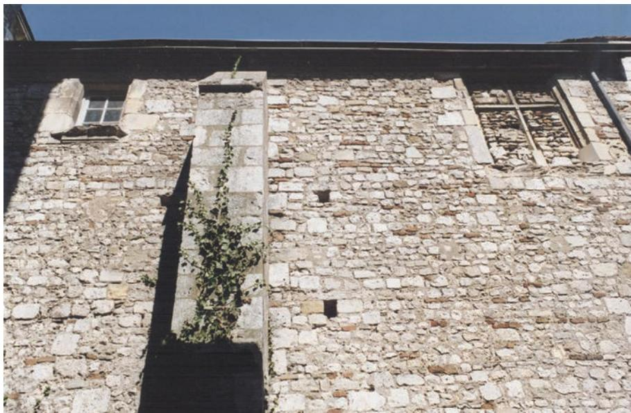
Fig. 9. Orléans (Loiret), Saint-Aignan, sacristie, mur occidental, vue extérieure (cl. P. Martin, 1998). Le petit appareil de moellons avec lignes et insertions de brique pourrait correspondre à une élévation du début du XI<sup>e</sup> siècle ; le contrefort et les baies semblent appartenir à un réaménagement de la construction à la fin du Moyen Âge.
