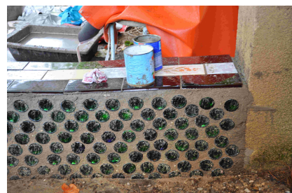
Fig. 3. Mur de soubassement (terre et bouteilles)
