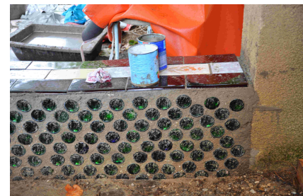
Fig. 3. Mur de soubassement (terre et bouteilles)
