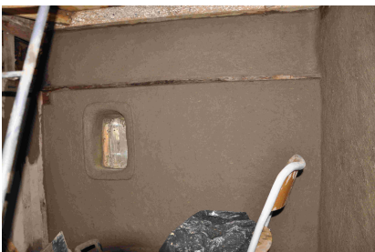
Fig. 1. Torchis et enduit terre Fig. 2. Cabane palette dans la cabane palette
