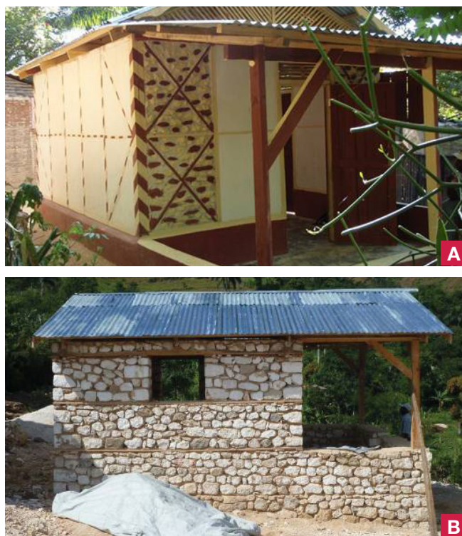
Figure 4. Programme de reconstruction, ONG Misereor, chantiers : (a) maçonnerie chaînée avec des pierres naturelles; (b) maison terminée à ossature bois avec remplissage en maçonnerie de pierres avec mortier terre. © C. Belinga et E. Cauderay
