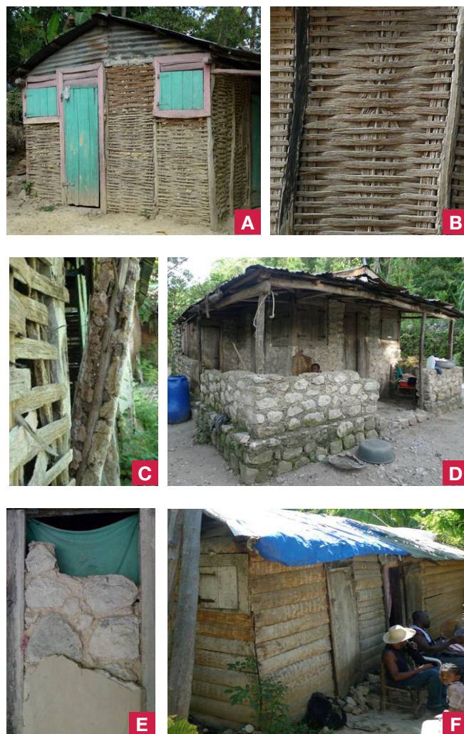
Figures 1. Techniques de construction :
