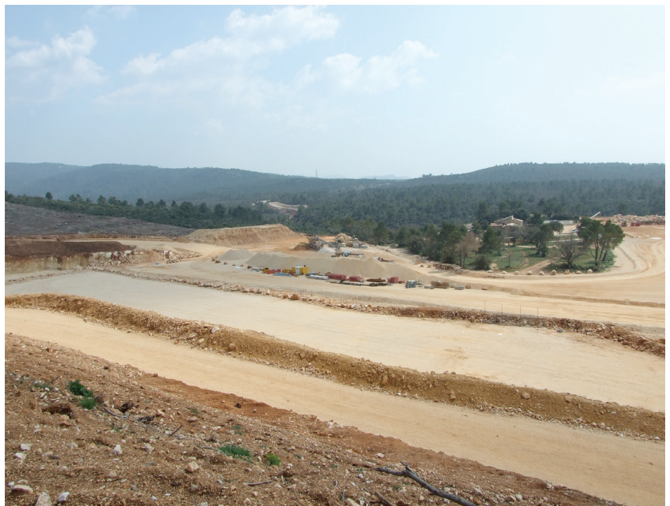
Figure 1 : Carrière de Croquefigue, au centre-droit emplacement de l'ancienne ferme, aujourd'hui base de vie.
