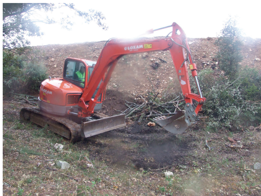
Figure 3 : Zone 2, mise à disposition pour le décapage d'une mini-pelle.
