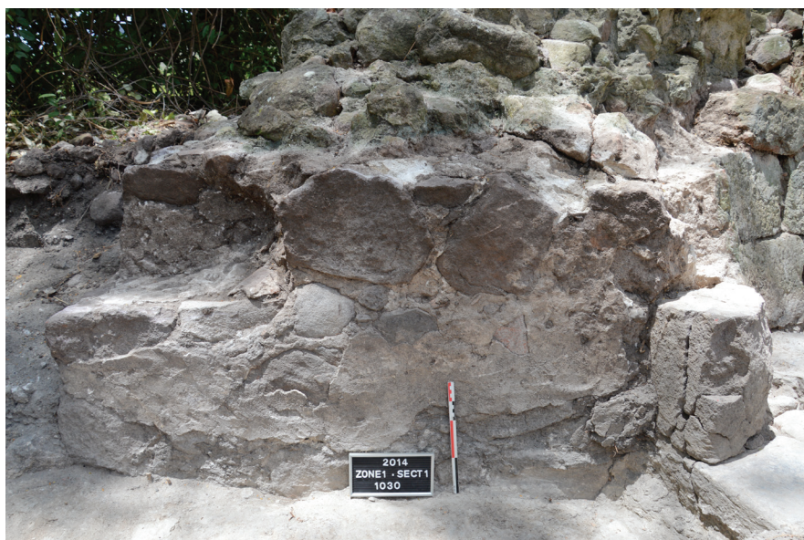
Figure 31 : ébrasement nord du couloir d'accès à la porte du foyer : le parement est couvert d'un enduit.
