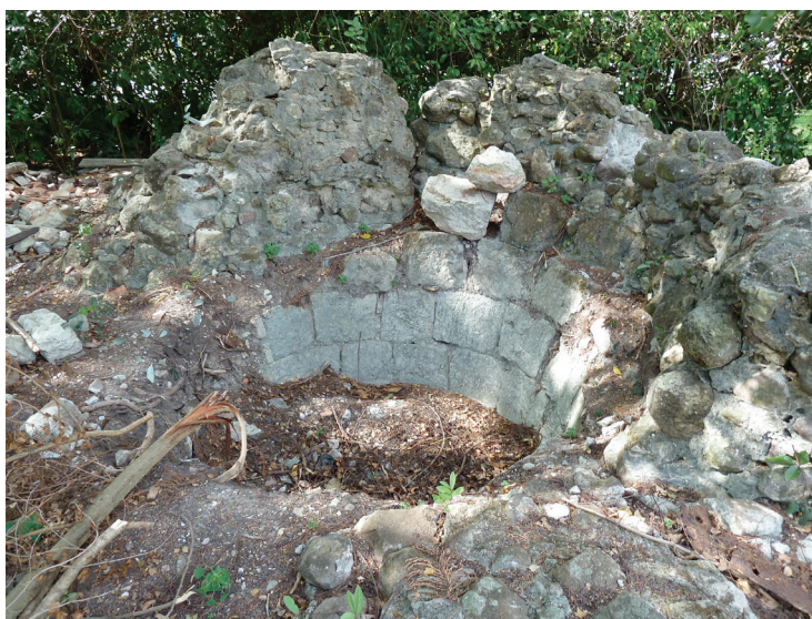
Figure 5 : le four à chaux.
