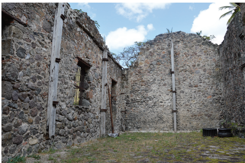
Figure 39 : intérieur du grand bâtiment, vue depuis l'ouest.
