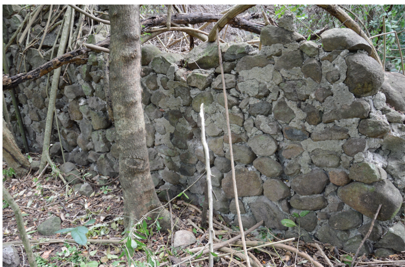
Figure 42 : détail du mur est du bâtiment rectangulaire.
