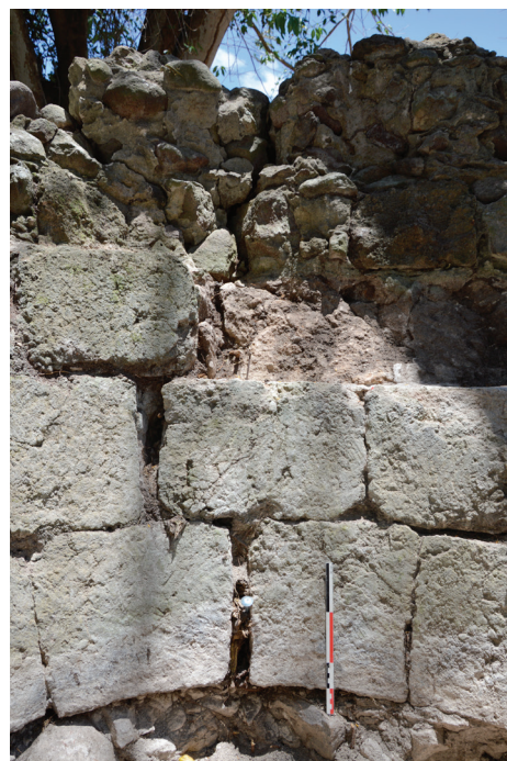
Figure 10 : détail du parement interne du mur MR1002.
