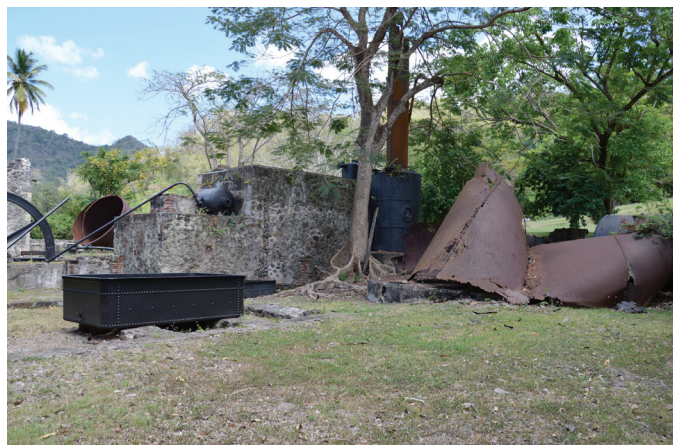
Figure 36 : à l'ouest de la chaudière : cheminée et citerne d'eau effondrée.
