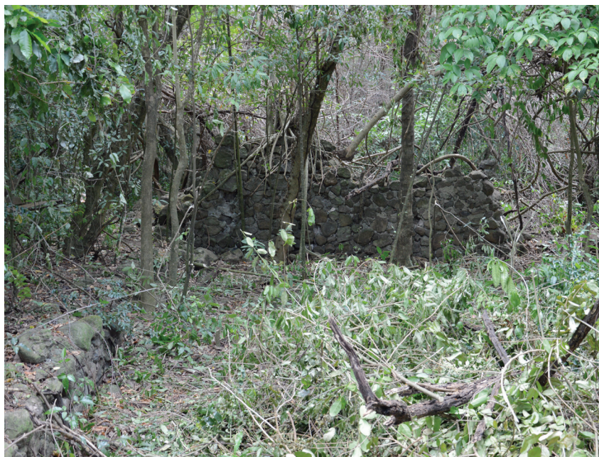
Figure 41 : au de-là du sol caladé, mur est d'un bâtiment rectangulaire pris dans la végétation.
