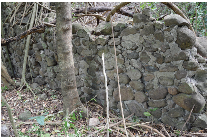
Figure 42 : détail du mur est du bâtiment rectangulaire.
