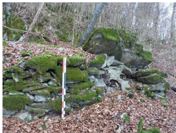
Fig. 121 : Portion du mur d'enceinte
