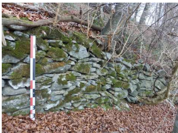
Fig. 122 : Mur de soutènement du chemin
