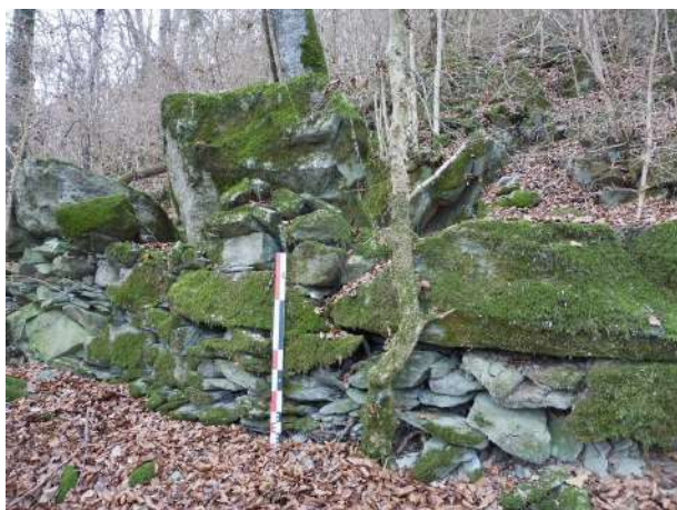
Fig. 120 : Portion du mur d'enceinte
