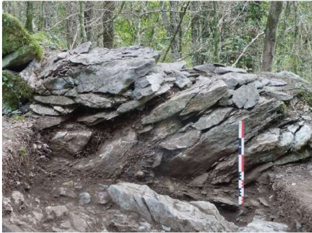
Fig. 72 : Parement ouest de MR101
