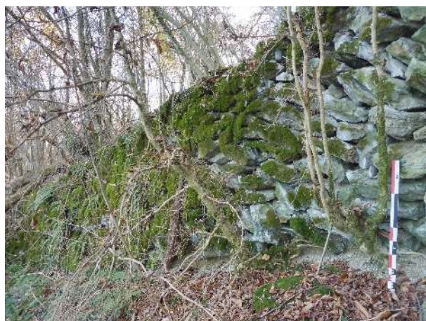
Fig. 123 : Mur de terrassement
