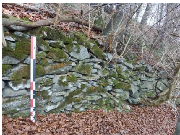
Fig. 122 : Mur de soutènement du chemin
