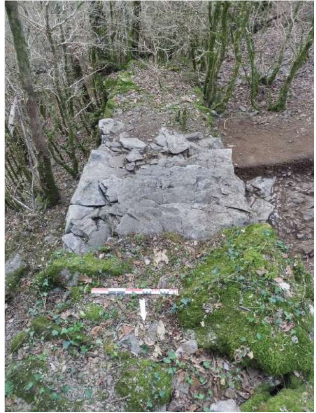
Fig. 69 : Vue générale de MR101 depuis le nord
